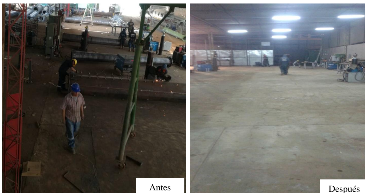
Figura 17. Antes y después (Limpieza).
