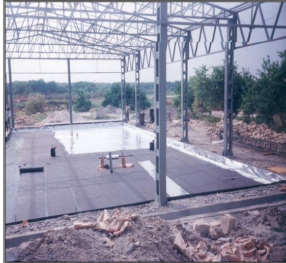
Figura 6. Fabricación y montaje de cámaras frigoríficas
