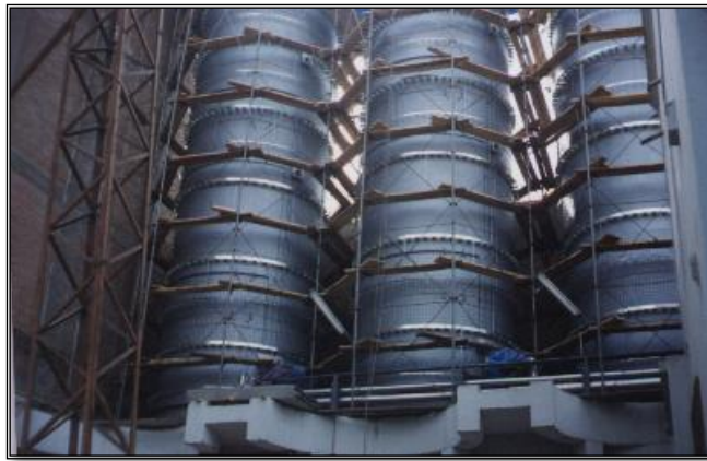
Figura 2. Aislamiento térmico de ductos con cañuelas de fibra de vidrio
