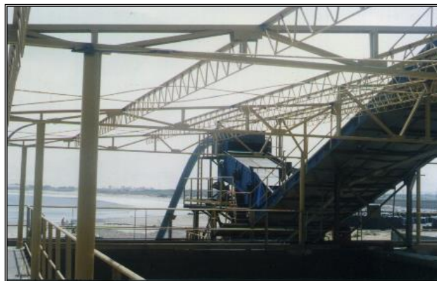
Figura 3. Fabricación y montaje de techo metálico
