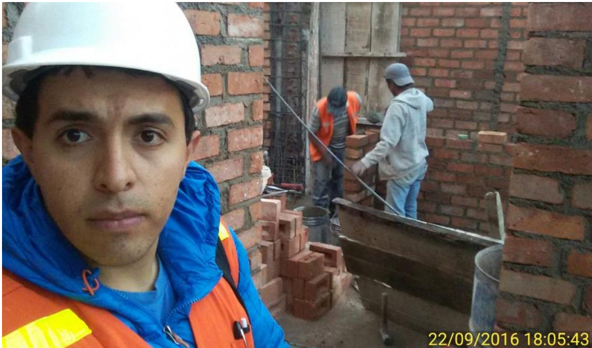
Ilustración 39: Construcción de muros de tabiquería
