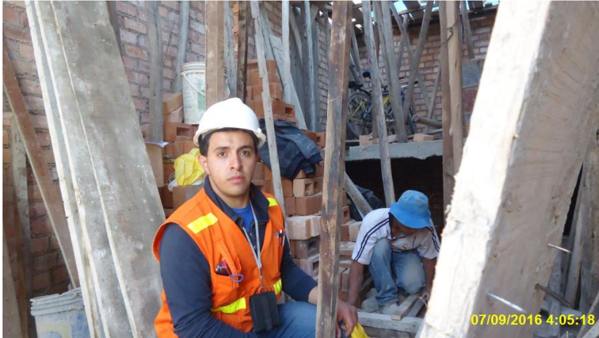
Ilustración 37: Encofrado de techo primer nivel
