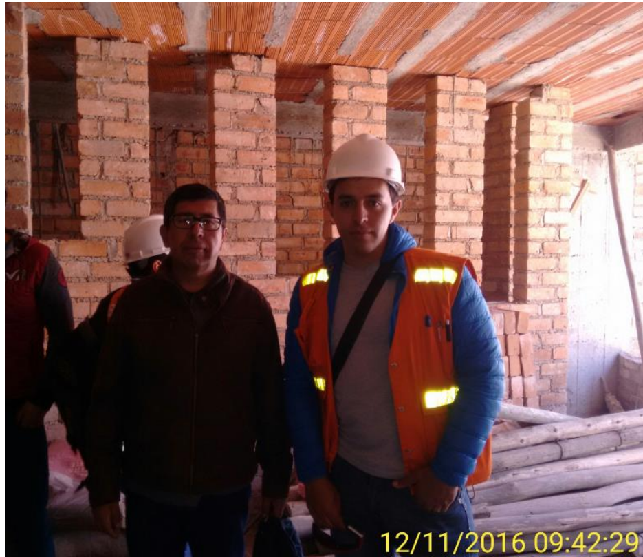
Ilustración 42. Visita a obra con el asesor Dr. Ing. Orlando Aguilar Aliaga
