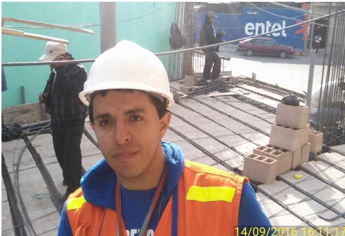
Ilustración 38. Trabajos en losa segundo nivel.
