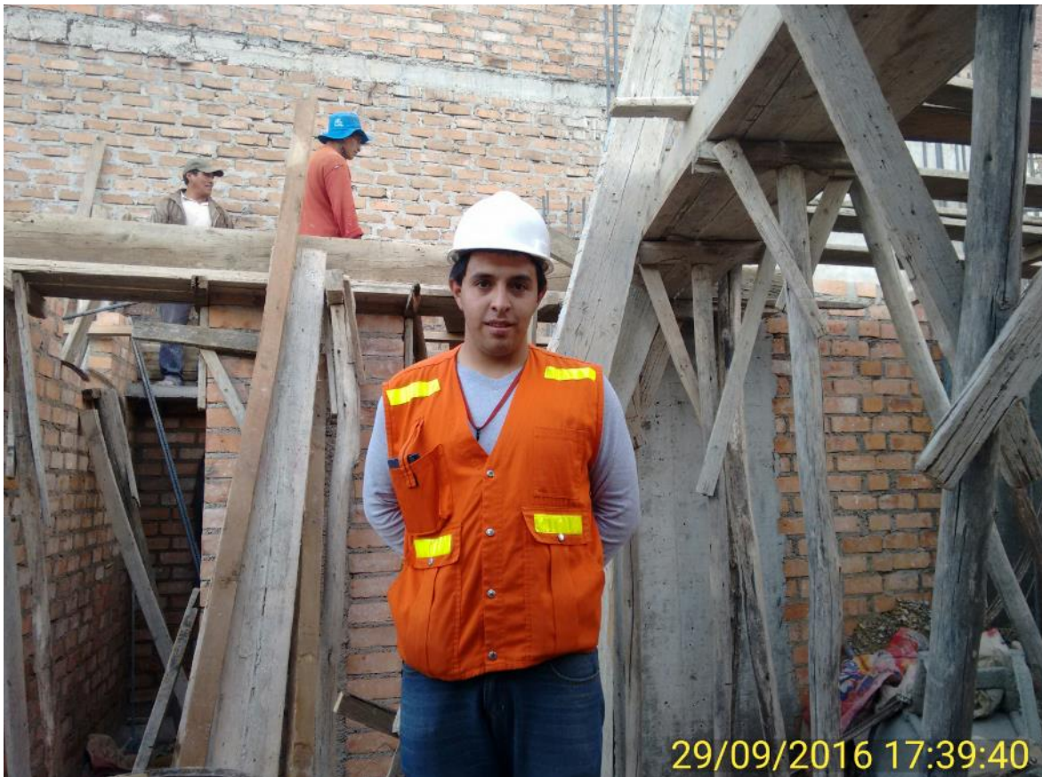
Ilustración 40. Visita a edificación en estudio, encofrado tercer nivel.
