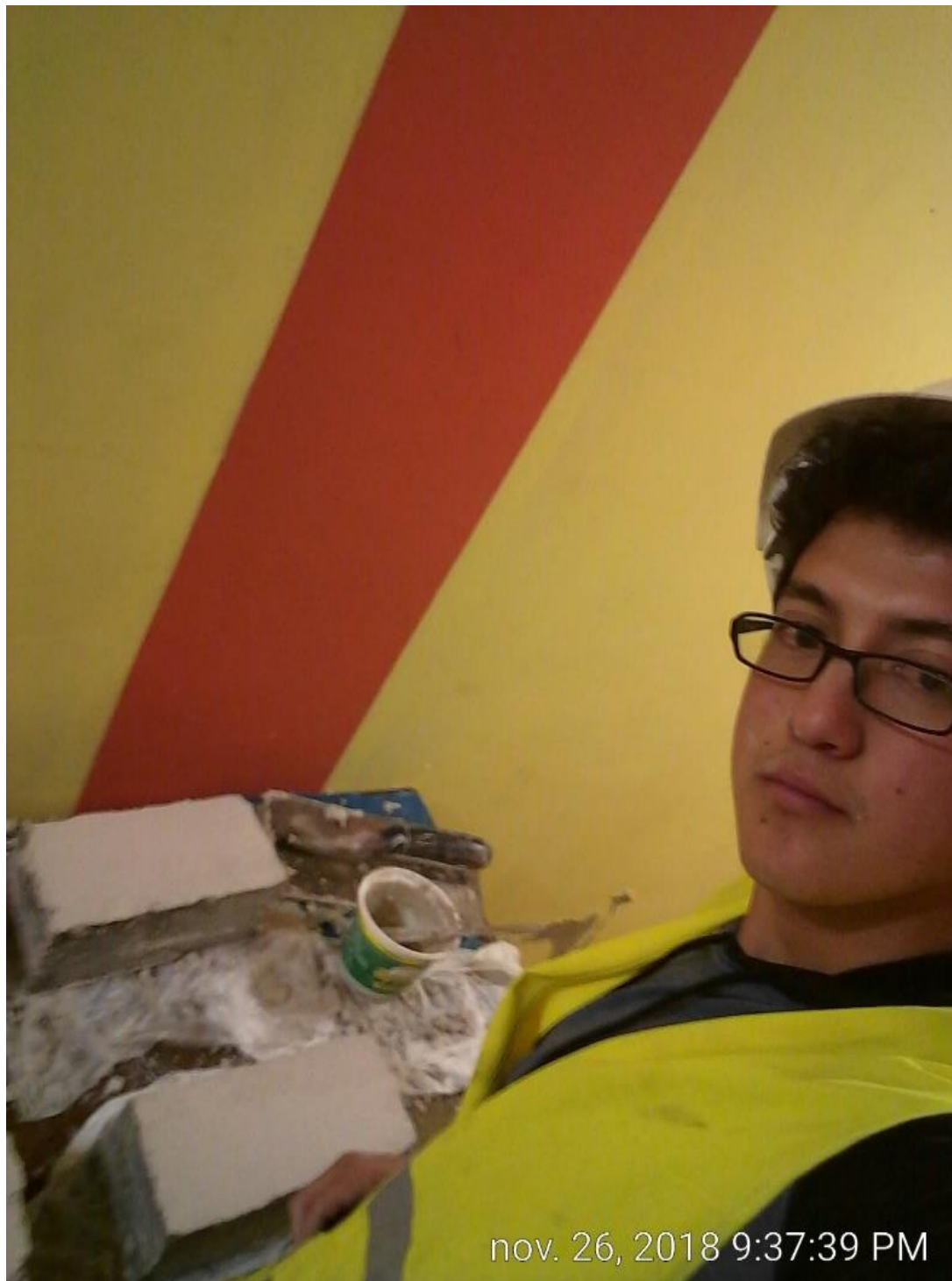
Figura 21. Enrasado con yeso de ladrillos de concreto
