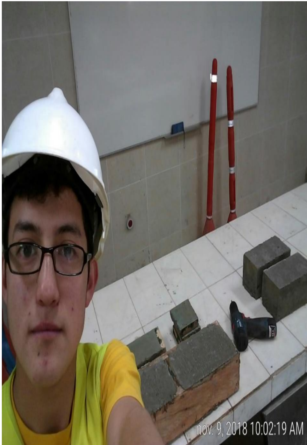
Figura 18. Desencofrado de ladrillos de concreto para curado a 28 días
