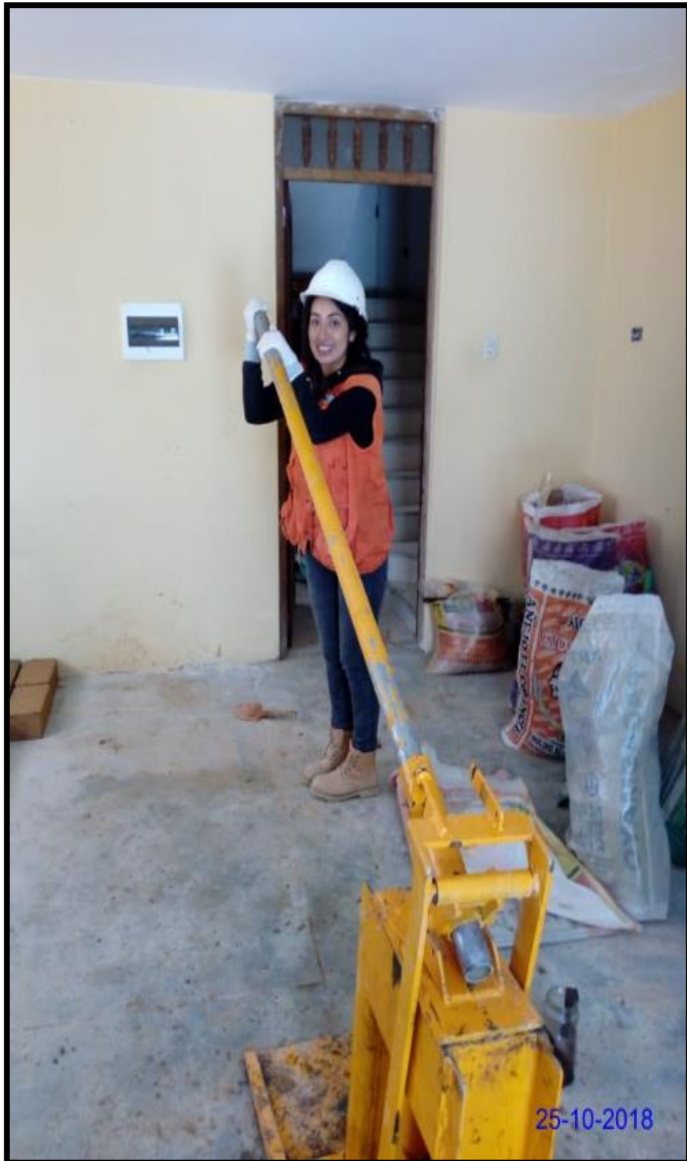
Fotografía N° 27: Elaboración del adobe compactado en la máquina CINVA-RAM.
