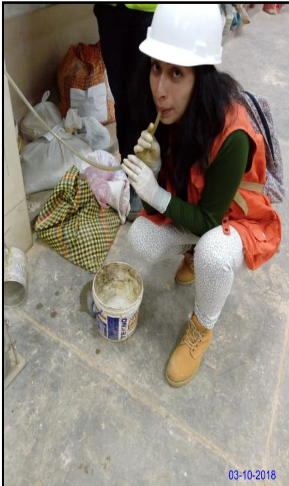
Fotografía N° 11: Succionando el material que esta sobre el disco metálico
