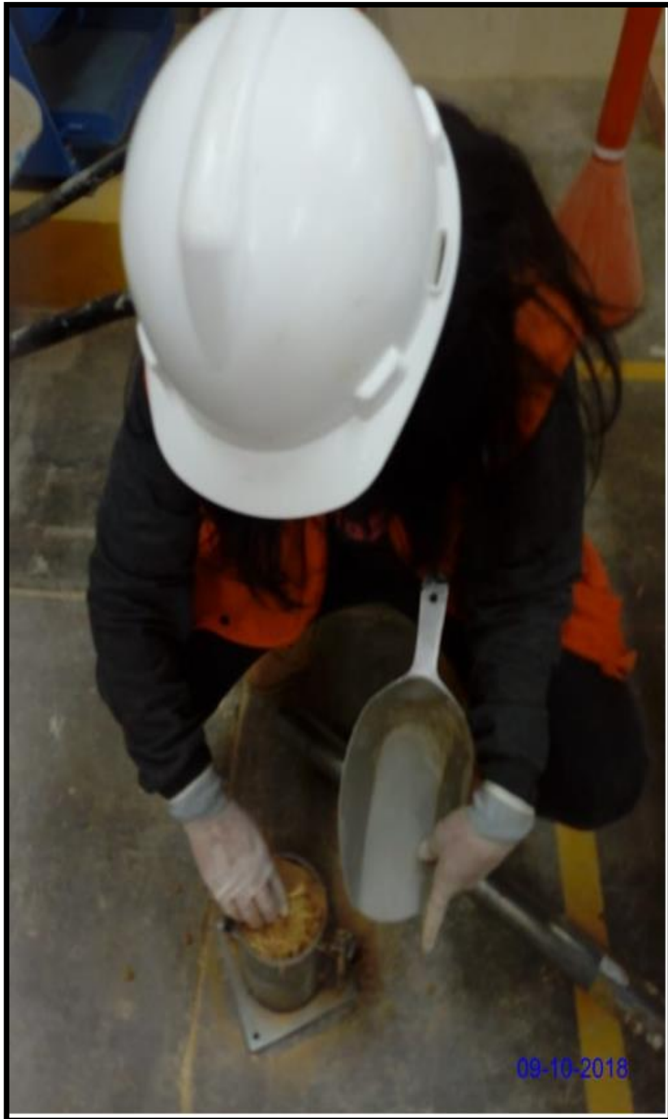
Fotografía N° 20: Colocación del material en el molde, perteneciente a la quinta capa.
