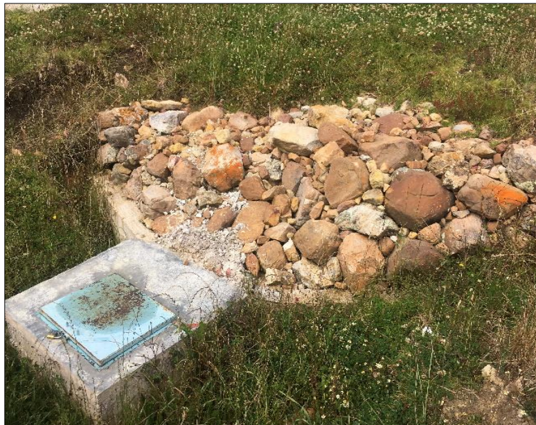
Fotografía 14 Captacion de ladera, Llushcapampa Baja.
