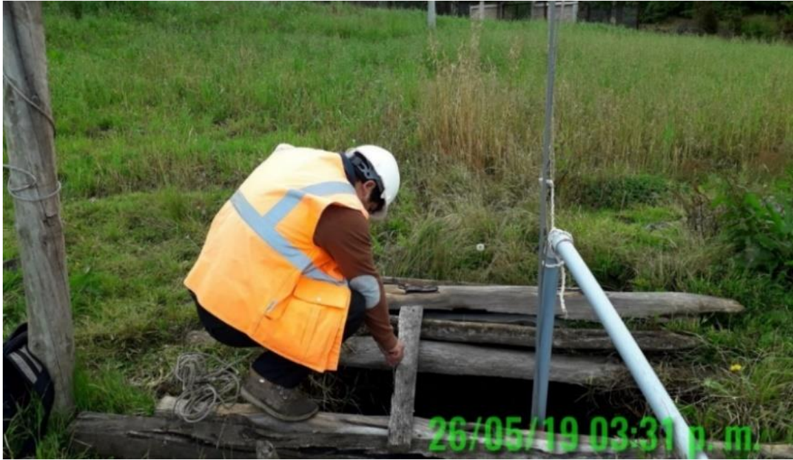
Imagen 7: Marca en hilo pozo lleno
