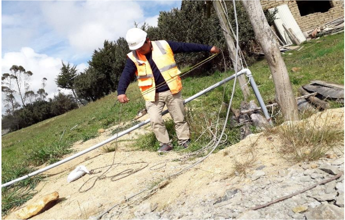
Imagen 8: Medida de altura de pozo lleno en hilo.
