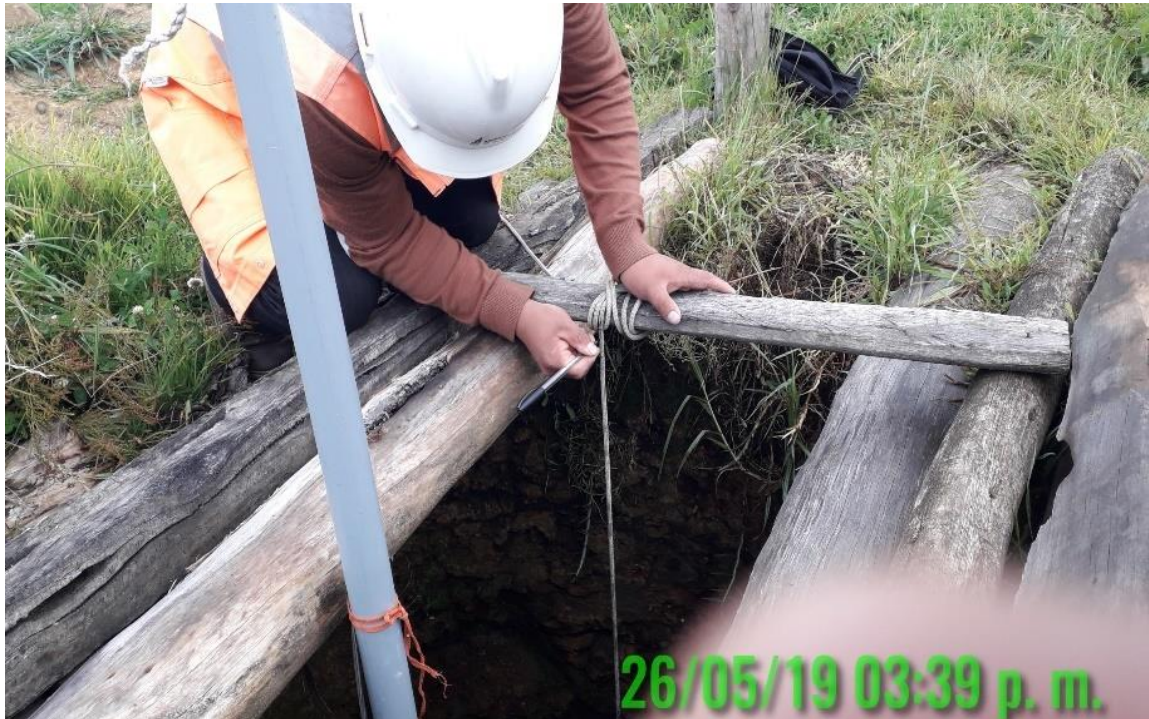
Imagen 4: Marca de altura en hilo pozo vaciado.
