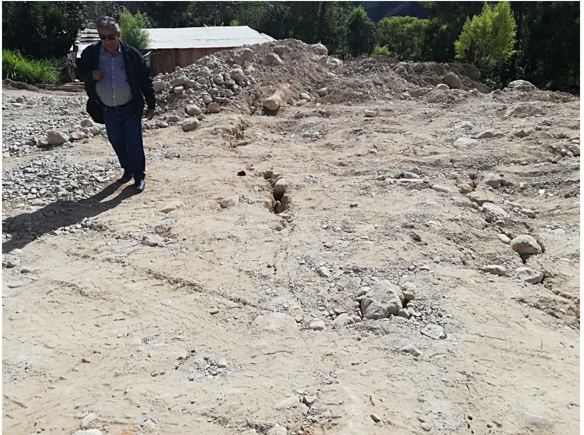
Figura 21: El suelo no es resistente a pesos excesivos como capas de relleno
