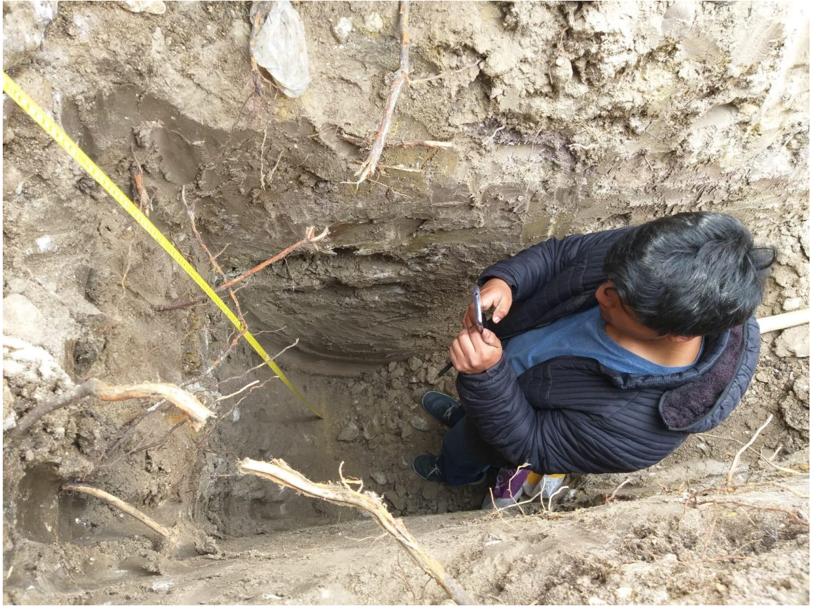
Figura 22: Calicata para sacar la muestra de suelo.
