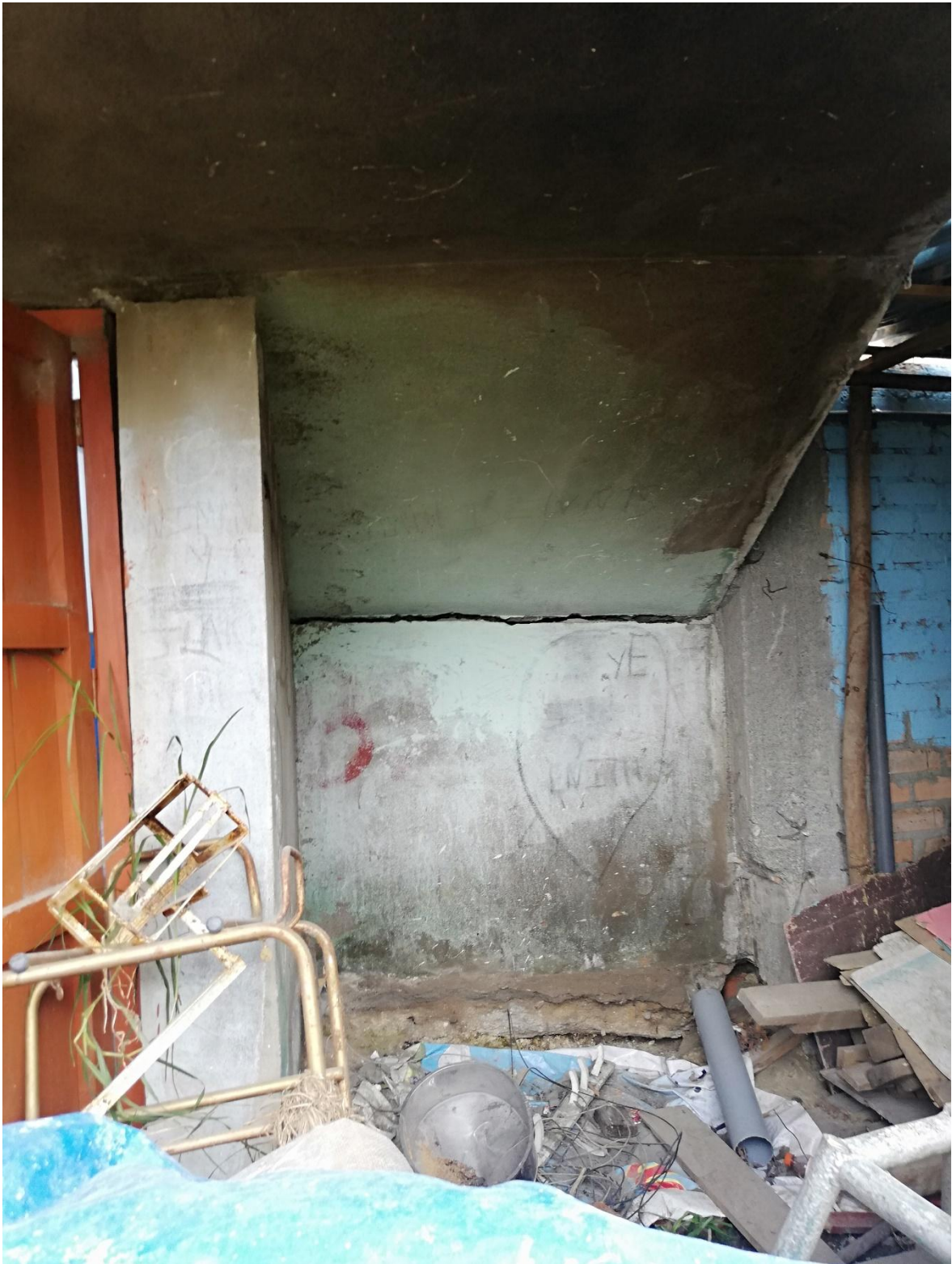
Figura 15: Separación entre la pared y las gradas del colegio Nuestra Señora de Lourdes
