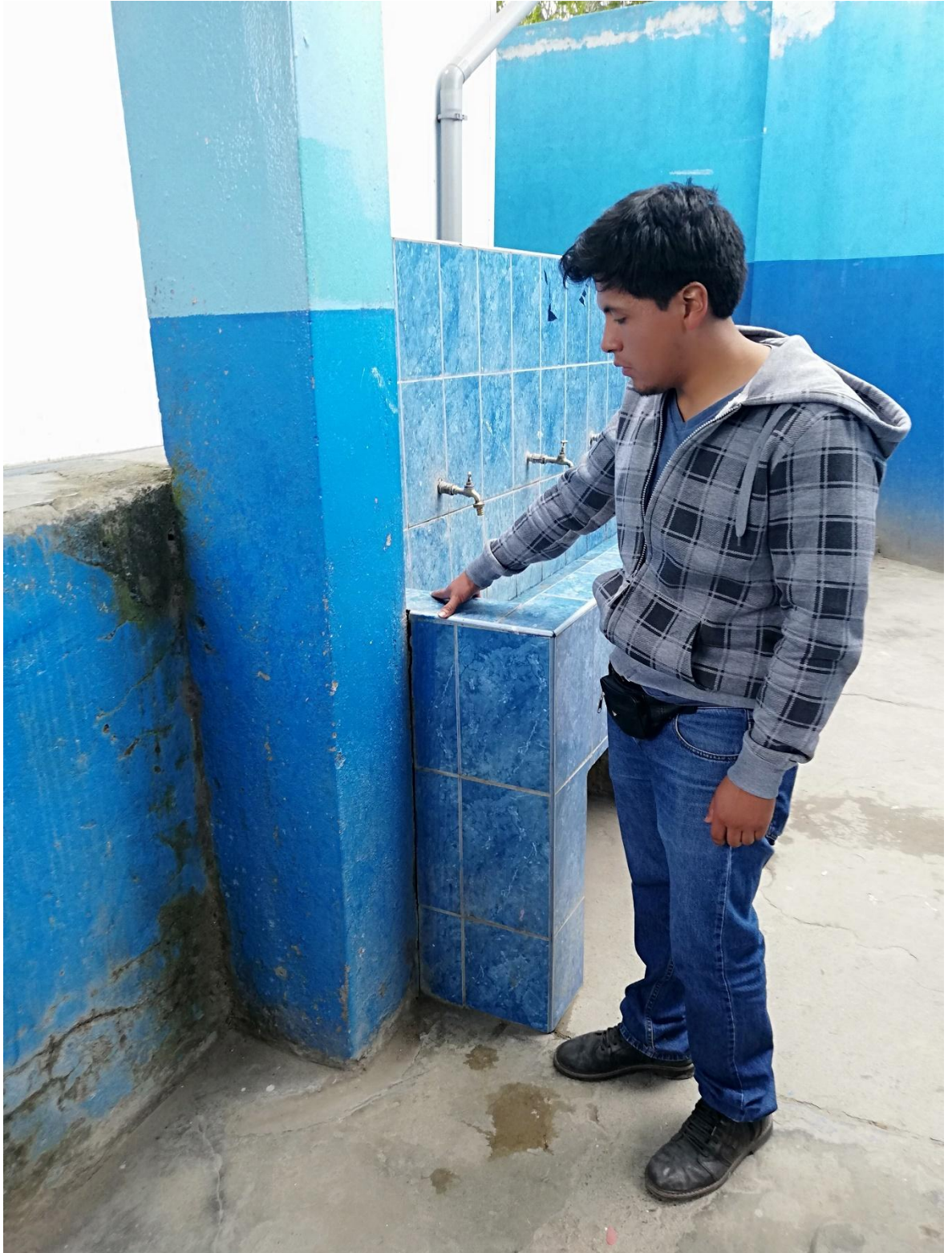
Figura 12: Despegue de los bloques de los Servicios higiénicos
