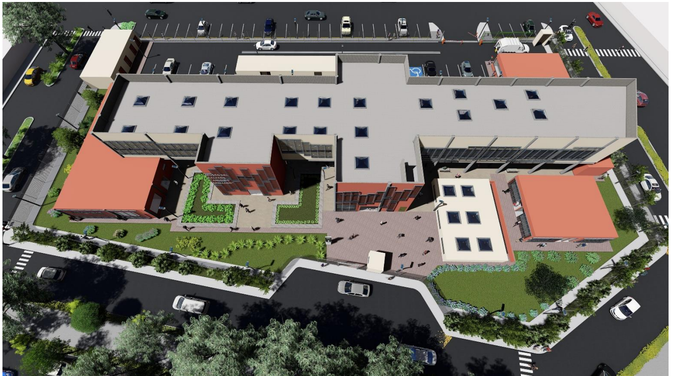
FIGURA N° 39: Vista General del Proyecto 02
