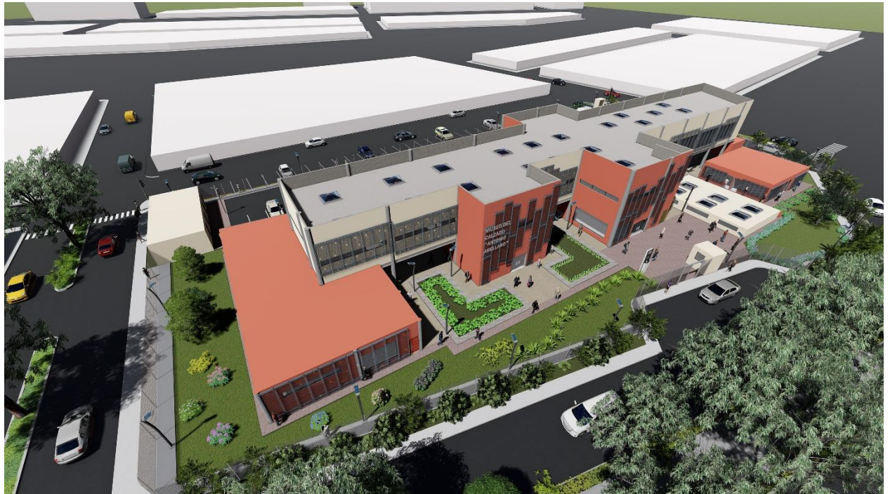
FIGURA N° 40: Vista General del Proyecto 03
