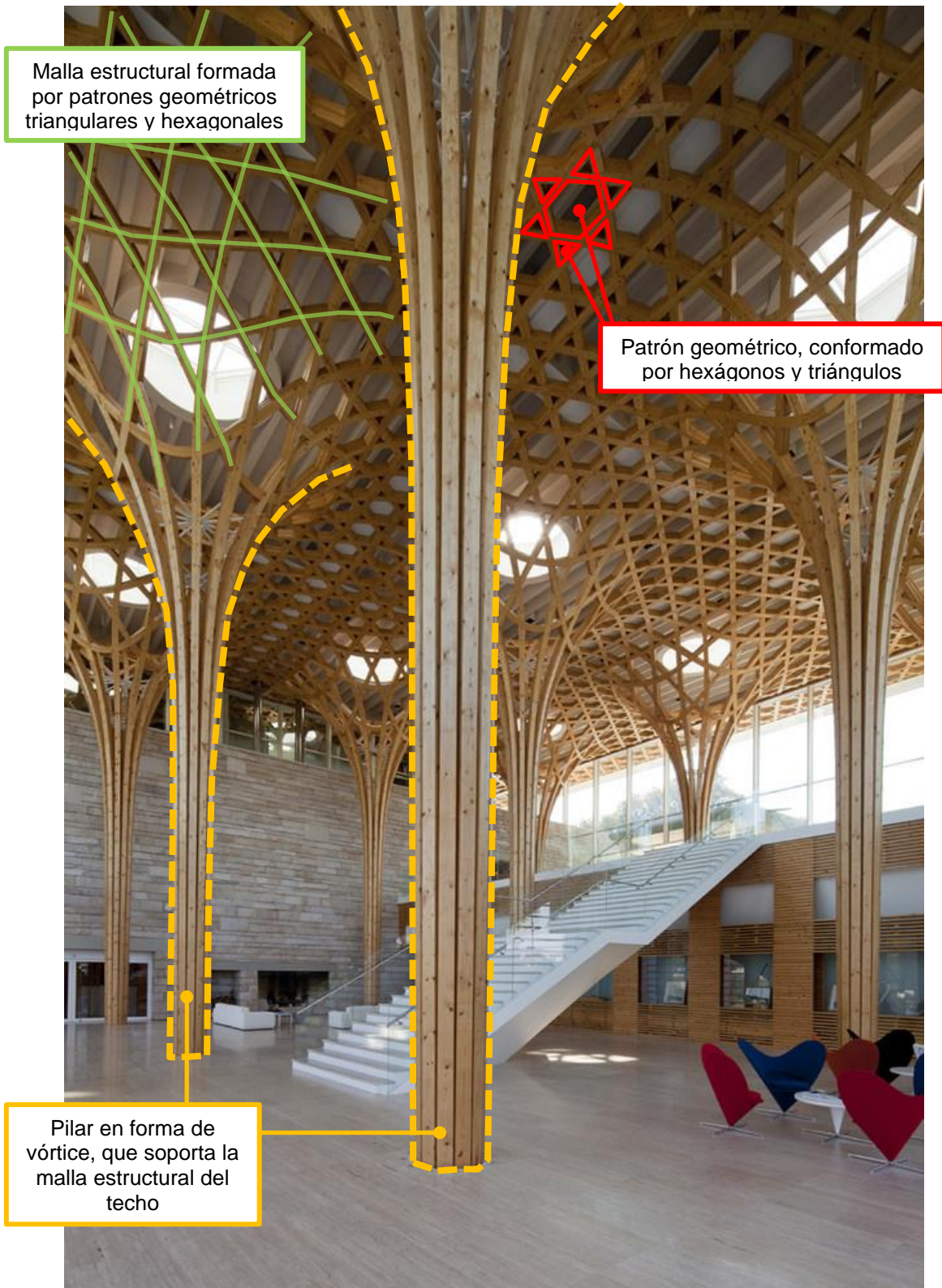
Foto 23 Vista interior, Club de Campo Nueve Puentes
