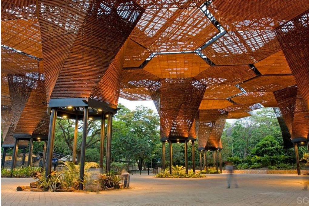
Foto 9 Vista de perspectiva del caso N° 07
