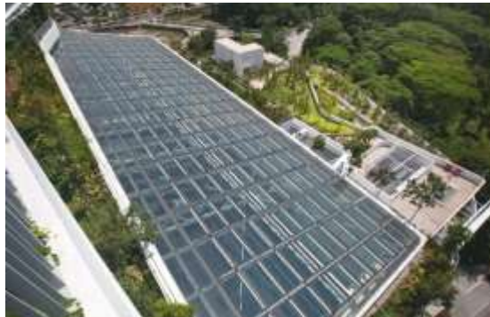
Imagen N° 11: Vista exterior de claraboya
