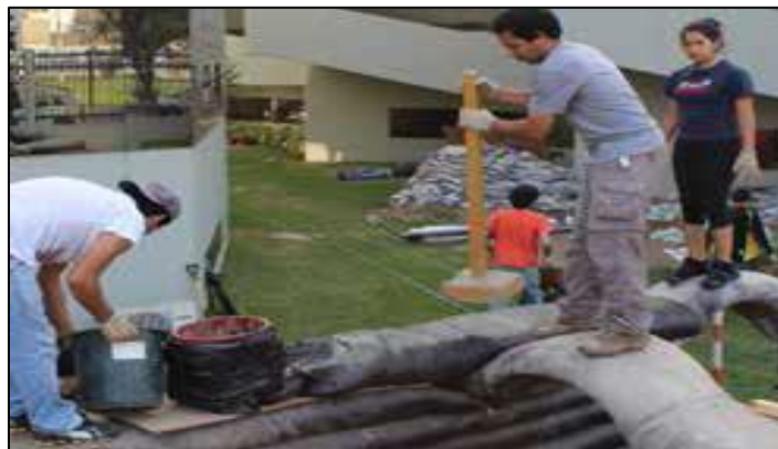
Figura 10 Compactación de la tierra con un pisón hasta tener una superficie plana y regular
