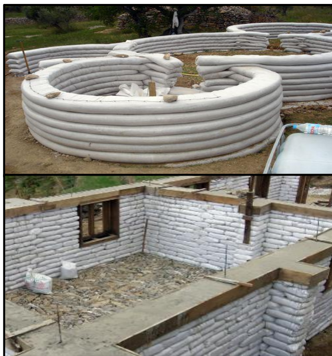
Figura 2 Estructuras con Earth-bag continuos (arriba) y con Earth-bag individuales (abajo)
