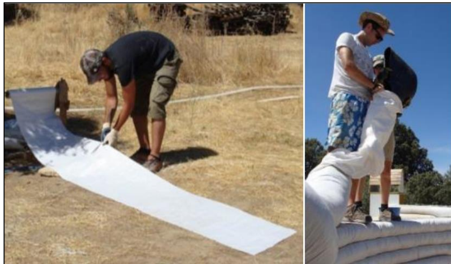
Figura 3 Sacos utilizados como encofrado para generar hiladas en los eco-domos
