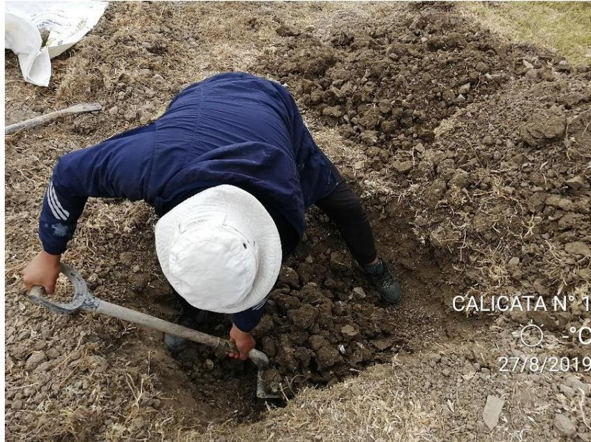
*Ilustración 10: Excavación de la Calicata N° 1 Progresiva Km 21+500.*
