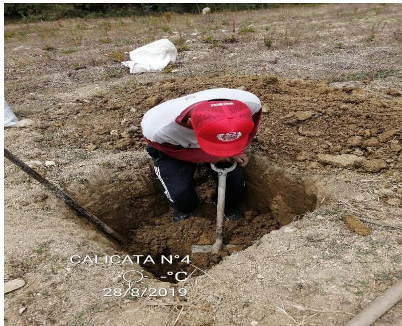
*Ilustración 13: Excavación de la Calicata N° 4 Progresiva Km 23.*
