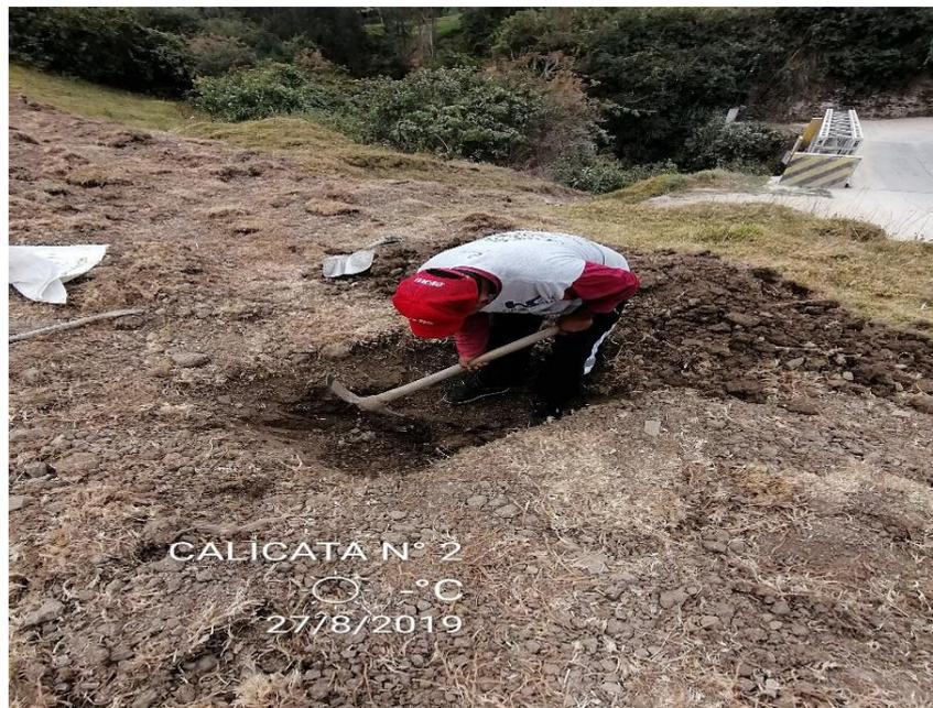
*Ilustración 11: Excavación de la Calicata N° 2 Progresiva Km 22.*
