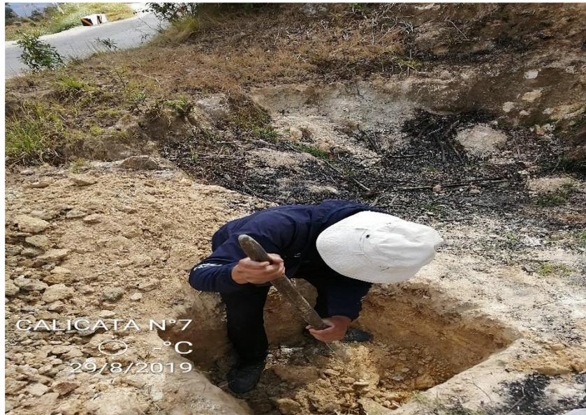
*Ilustración 16: Excavación de la Calicata N° 7 Progresiva Km 24+500.*
