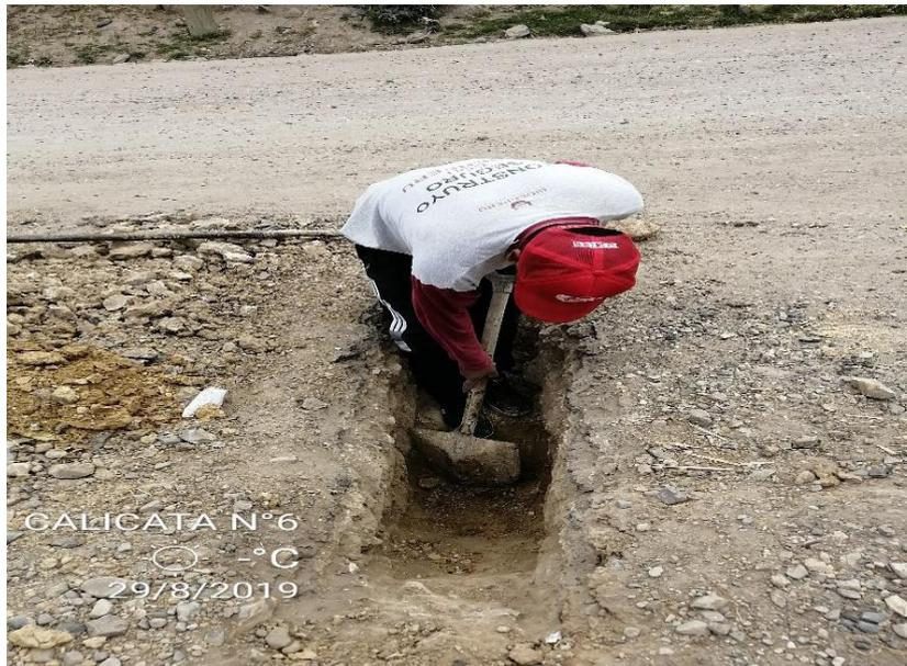
*Ilustración 15: Excavación de la Calicata N° 6 Progresiva Km 24.*
