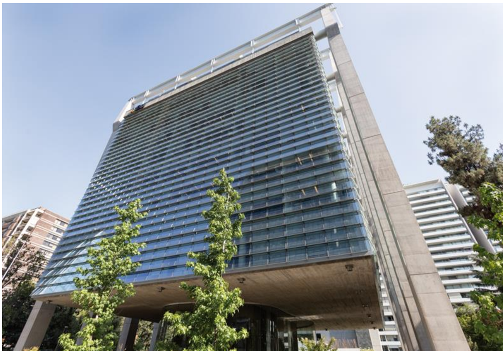
Figura 2: Vista Lateral del edificio de 10 niveles con sistema semi-colgante en la ciudad Alcántara, Chile, donde se aprecia la unión de las vigas peraltadas a las columnas externas edificio.
