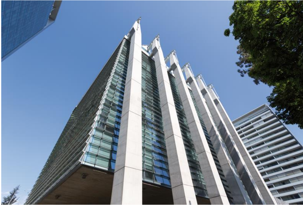
Figura 1: Vista en diagonal del edificio de 10 niveles de con sistema semi-colgante en la ciudad Alcántara, Chile, donde se aprecian los 6 pilares que resisten parte de todo el peso de la estructura.
