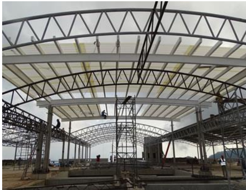
Figura 8: Sistema estructural con perfiles de acero.
