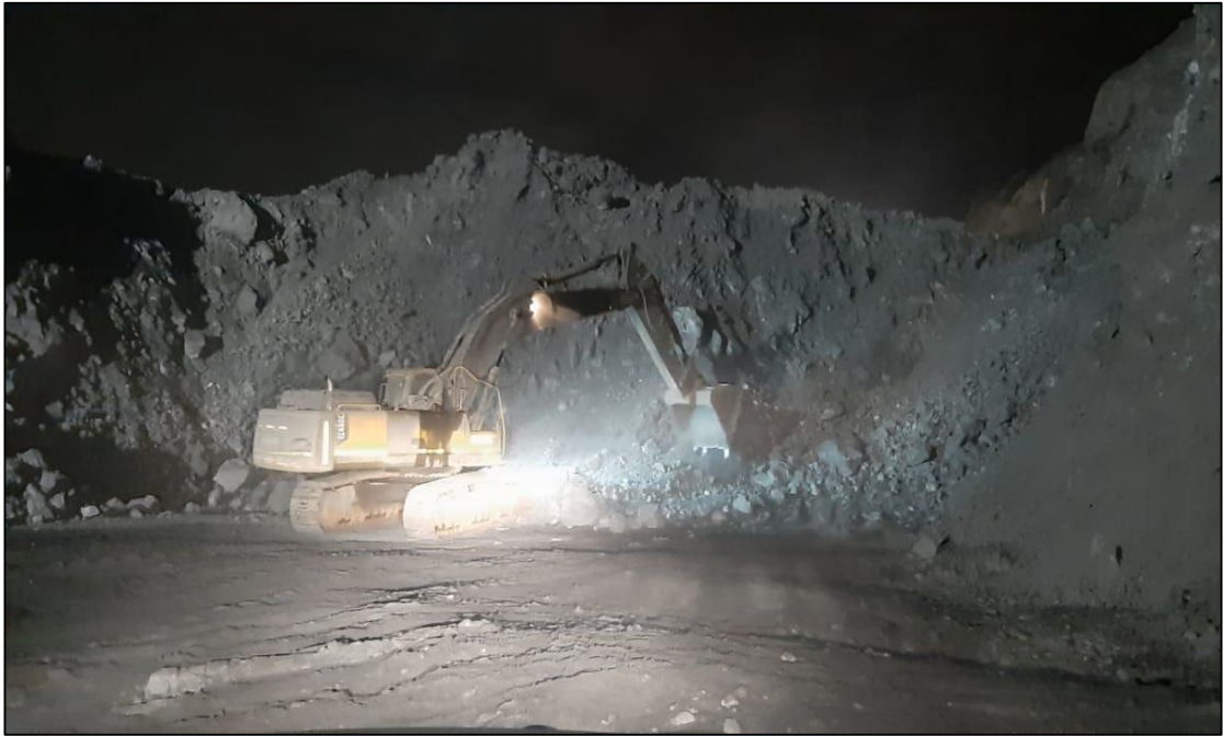
Figura 21. Excavadoras CAT390 de la empresa San Martín.
