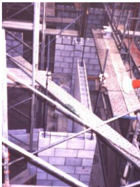
Figura 3: Albañilería Armada (San Bartolomé, 2008)
