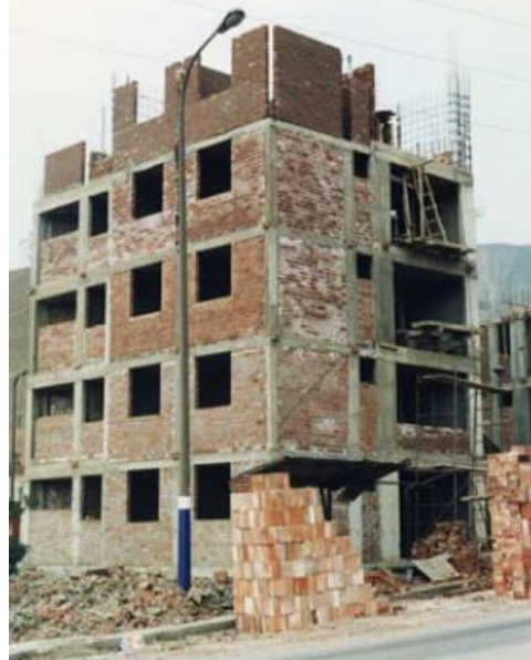
Figura 2: Albañilería confinada (Torre,2012)
