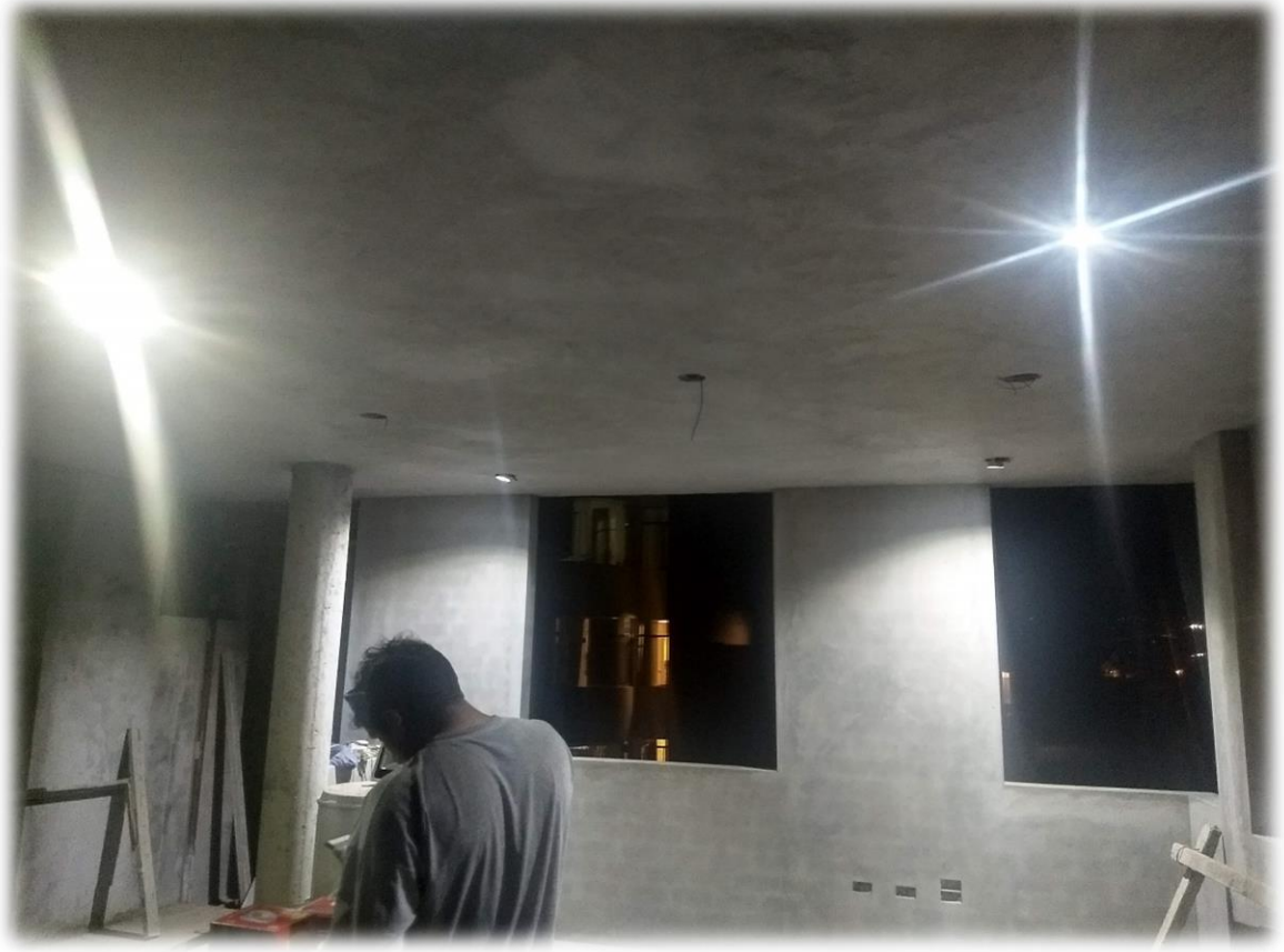
Figura 36: Las luminarias interiores y exteriores son de la red pública, no cuenta con instalación de energía renovable.
