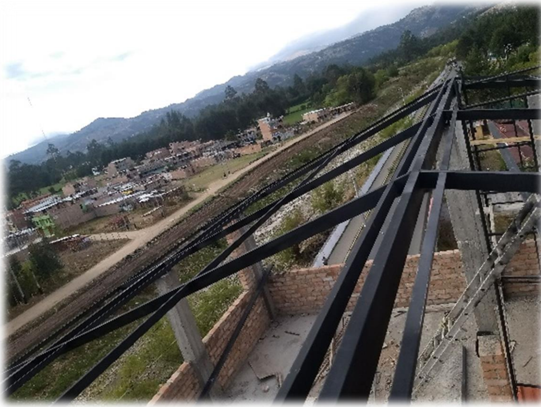
Figura 42: Techo metálico con calamina, no cuenta con capa vegetal en el techo para controlar aguas de lluvia.
