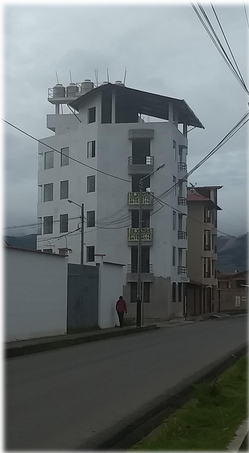
Figura 40: La edificación al estar ubicada en esquina contempla la utilización de luz natural.
