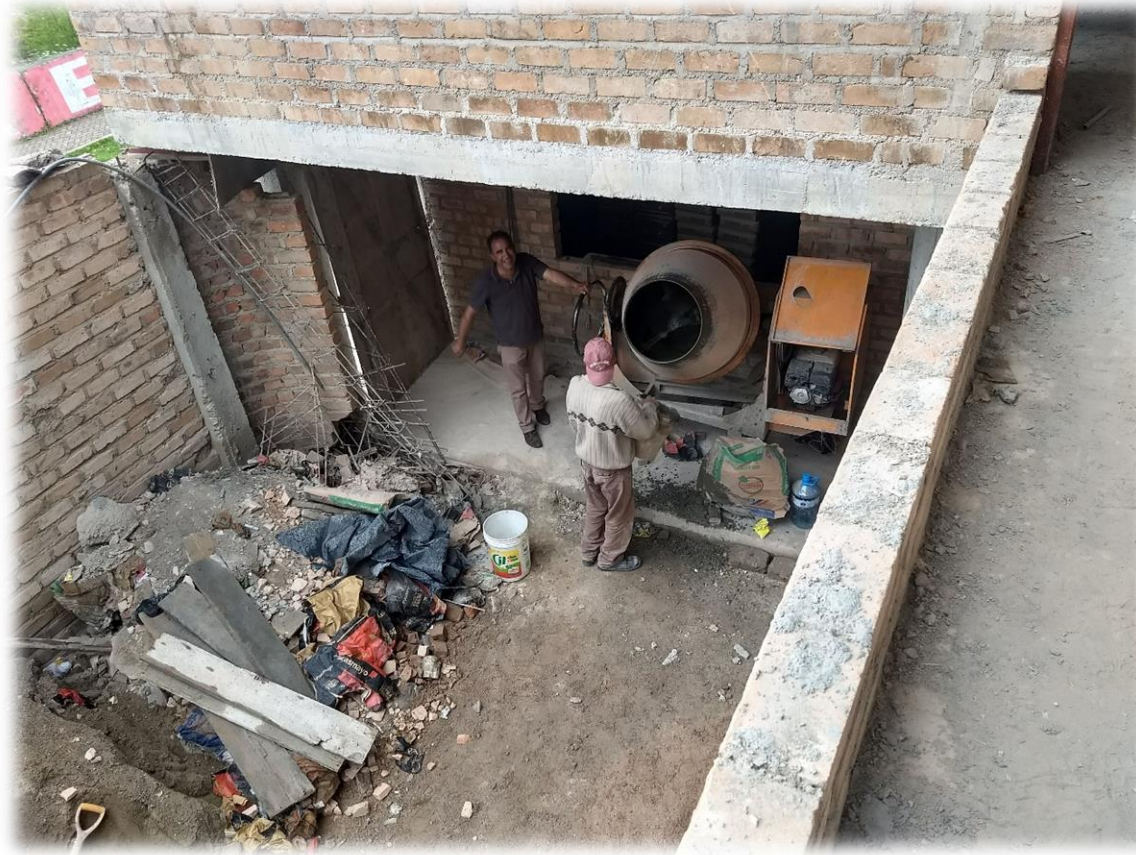
Figura 32: No cumple con los prerequisites de “almacenamiento y recolección de reciclaje” ni “planificación de gestión de desechos de construcción y demolición”
