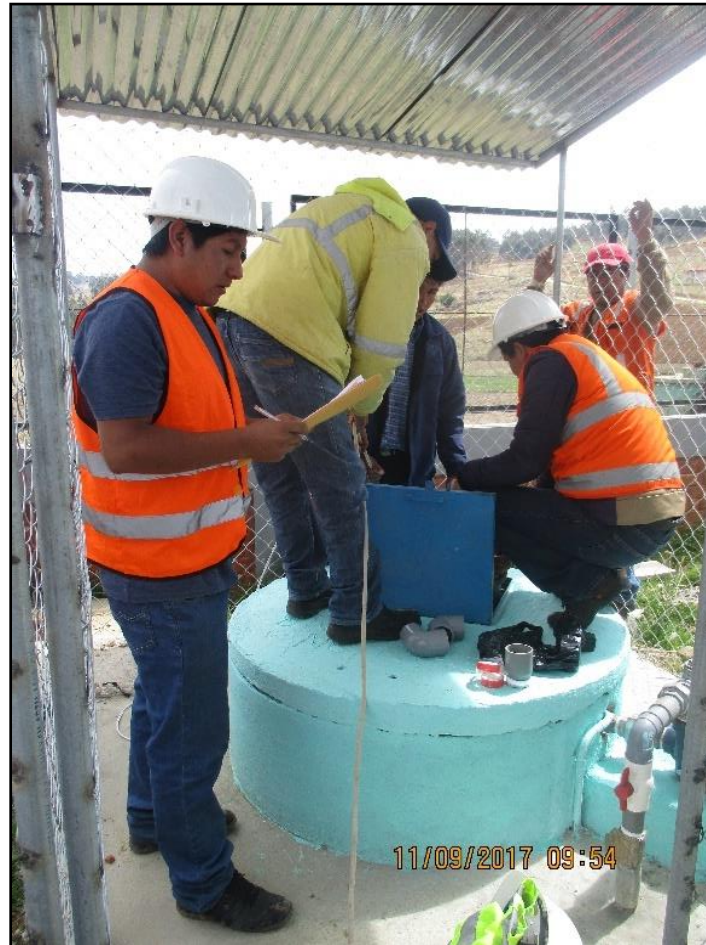
Figura 5: Equipo de trabajo realizando la instalación de la electrobomba.
