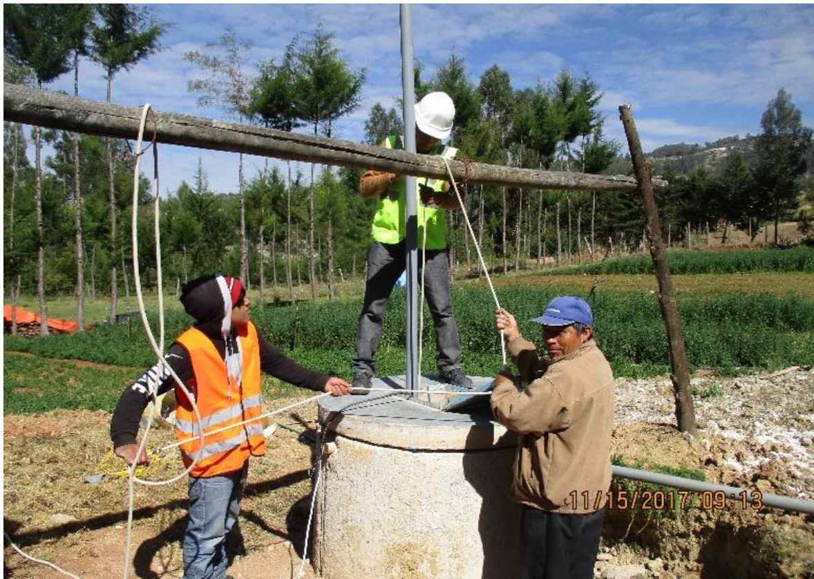
Figura 34: Instalando la tubería para bombeo en el pozo de propiedad del Sr. Antonio Novoa Pachamango.
