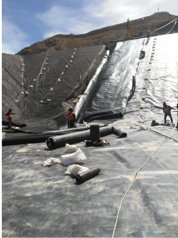
Imagen 41 Tendido capa secundaria
