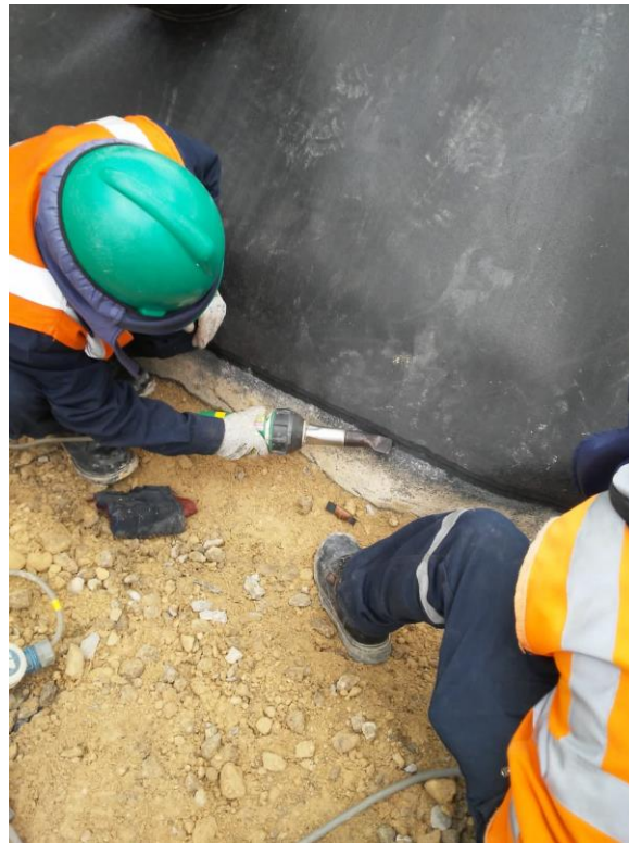
Imagen 34 Equipo de cuña caliente en ejecución
