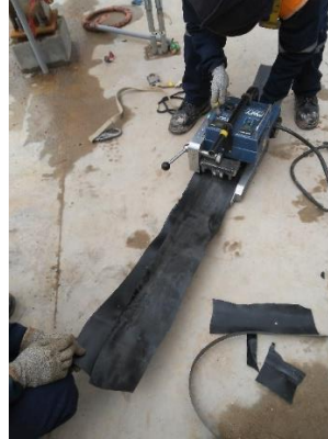
Imagen 15 Soldadura Por Fusión
