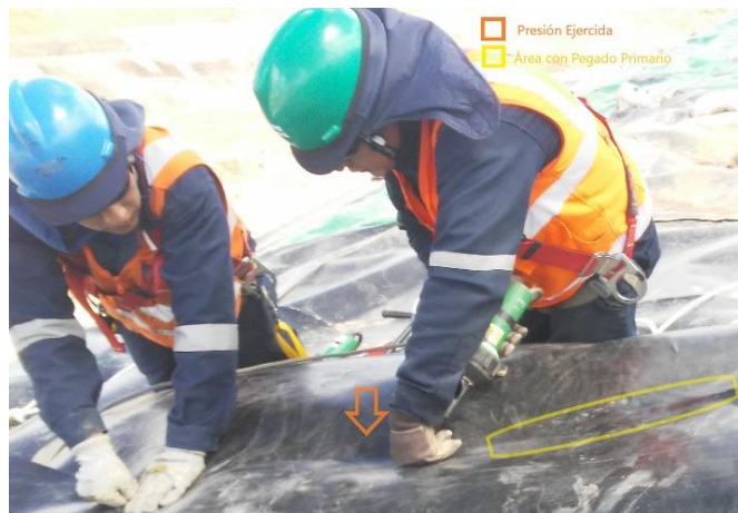
Imagen 18 Pegado Primario Soldadura Extruida
