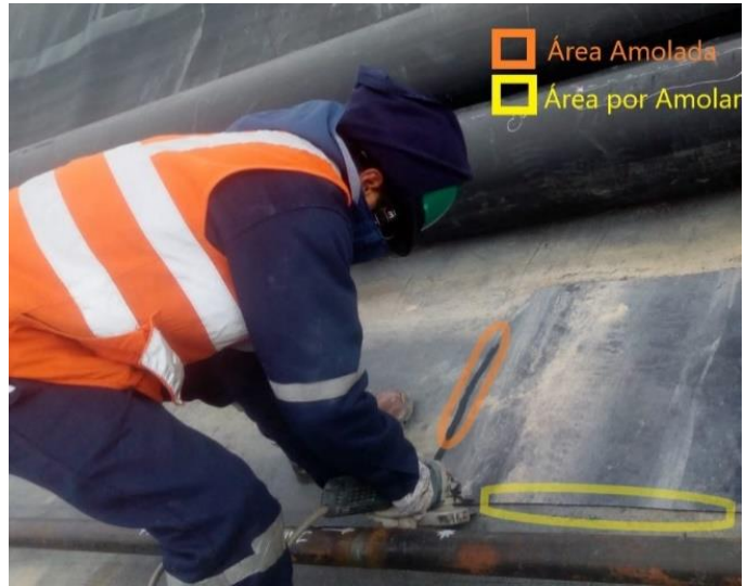
Imagen 19 Amolado Soldadura Extruida
