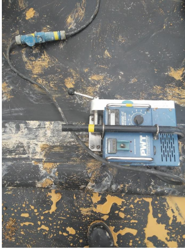
Imagen 35 Instalación de cobre previo a soldadura por extrusión
