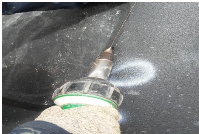
Imagen 20 Colocación de Cobre Soldadura Extruida
