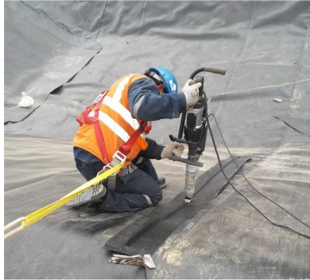
Imagen 21 Soldadura por Extrusión
