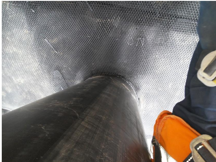
Imagen 40 Conformación de sangría en tubería de ZAN
