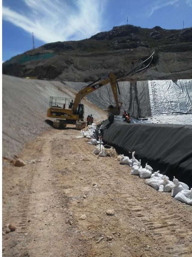
Imagen 43 Despliegue de capa secundaria desde zona acceso de mantenimiento.
