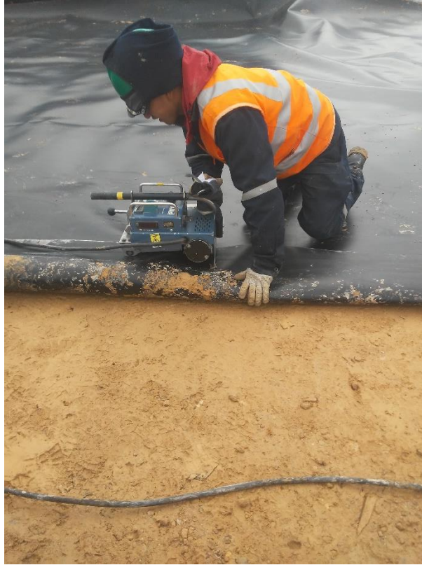
Imagen 33 Soldadura por termofusión en paneles
