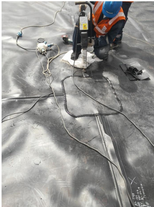
Imagen 36 Soldadura por extrusión (Instalación de parche)
