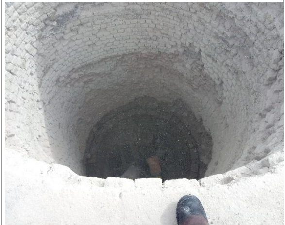
Fotografía 6. Vista interior de un horno de 15 t de capacidad.
