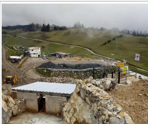
Fotografía 1. Vista panorámica de la Planta de producción Cumbe Mayo.
