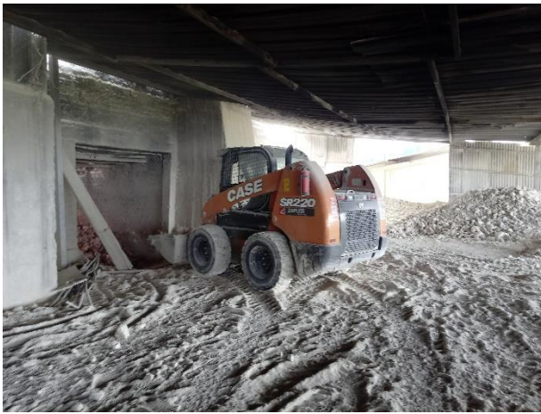
Fotografía 5. Minicargador utilizado para el transporte de CaO granulada hacia el almacén.
