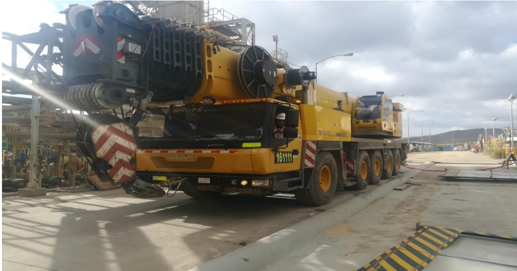
Figura 11: Equipo de izaje necesario para el montaje de reductor y motor. La grúa debe tener un alcance de 30 mts de longitud.
