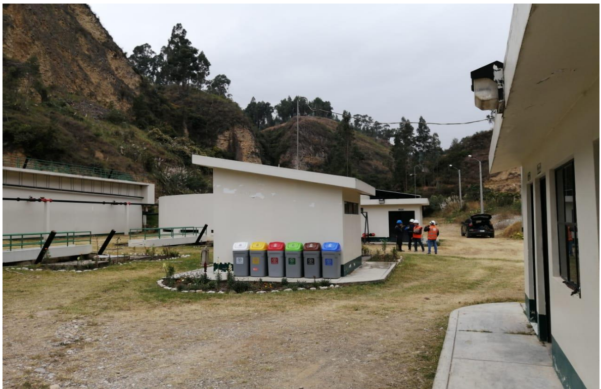
Figura 35. Implementación de manejo de residuos sólidos en la Planta de Tratamiento.
