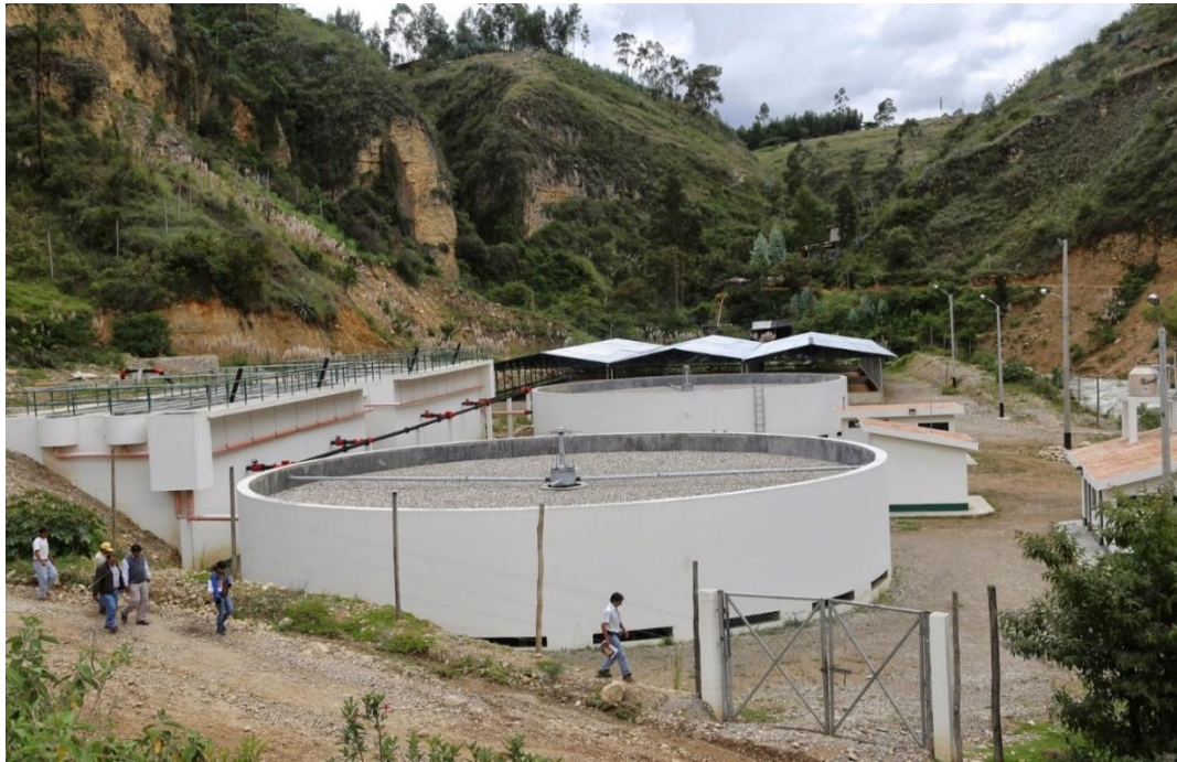
Figura 4. Entrada principal de la Planta de Tratamiento de Aguas Residuales del Sector Ojo de Lanla de la Ciudad de Cajabamba
