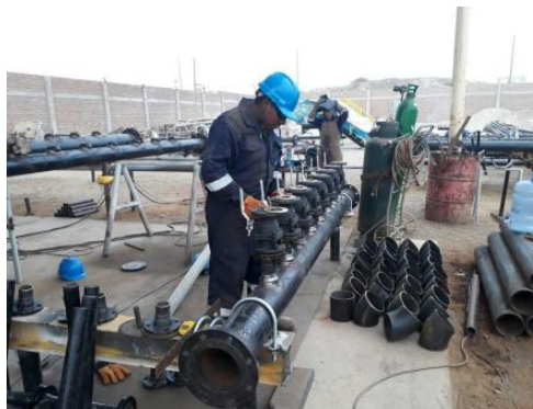
FIGURA 16: Construcción de manifold
