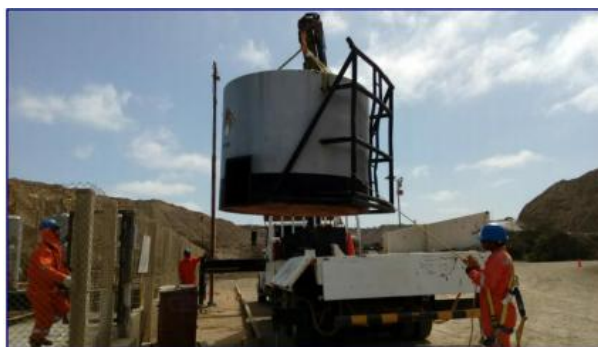
FIGURA 12: Izaje de cargas y montaje
