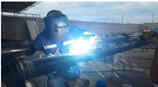
FIGURA 15: Mantenimiento de ductos
