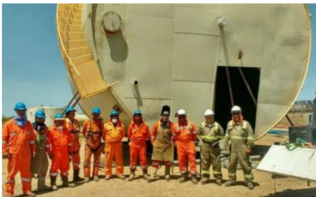
FIGURA 14: Obras de mantenimiento
