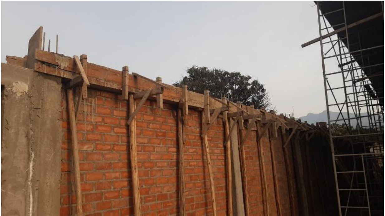
Figura 39. Encofrado y vaciado de vigas
