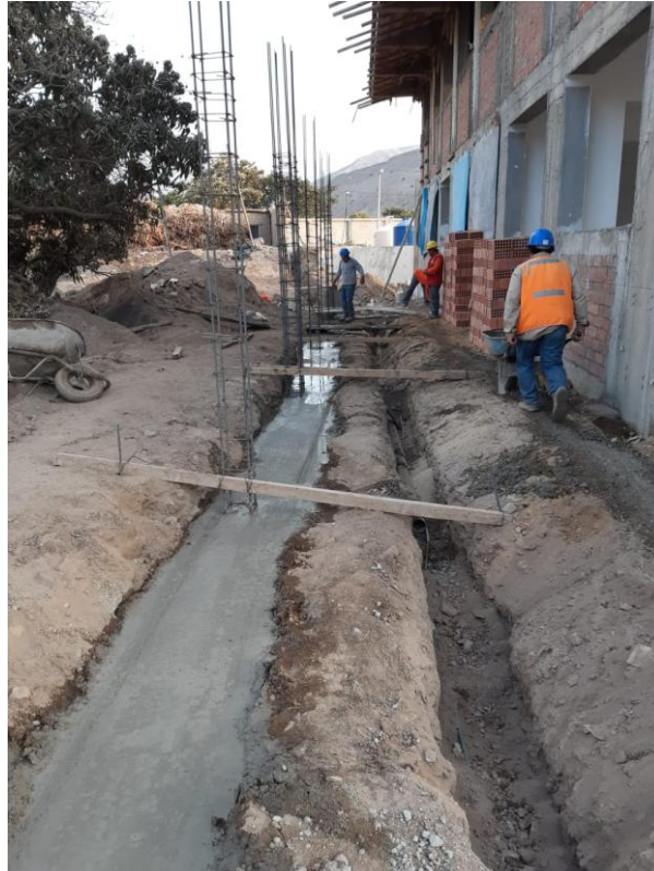
Figura 33. Actividad de vaciado de concreto ciclópeo en cimiento corrido
