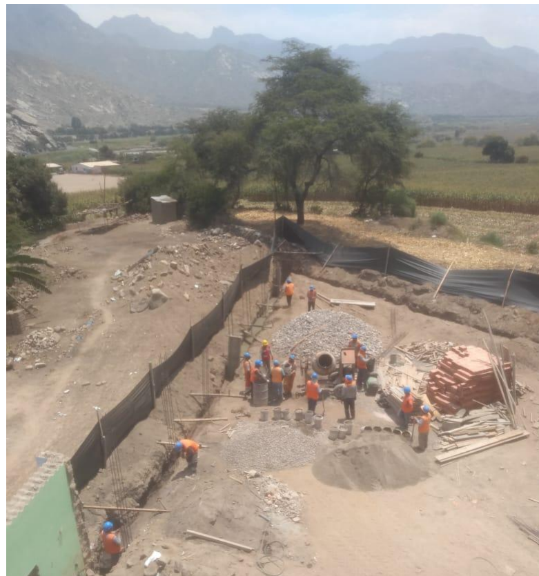
Figura 32. Actividad de vaciado de concreto ciclópeo en cimiento corrido.
