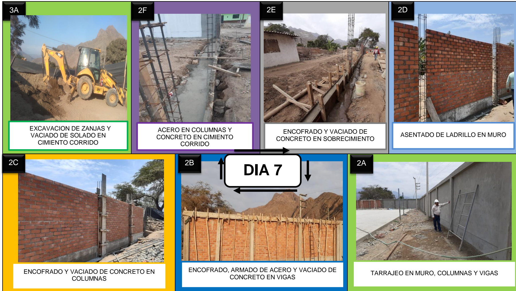
Figura 12. Partidas correspondientes al tren de actividades. Adaptado de A. Guzmán, 2014, “Aplicación de la Filosofía Lean Construction en la planificación, programación, control y ejecución de proyectos” Tesis de Pregrado, pág. 57.
