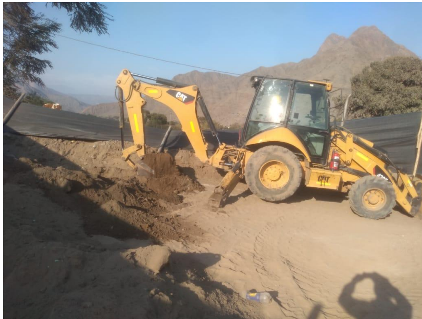
Figura 31. Actividad de excavación con maquinaria pesada de zanja para cimiento corrido
