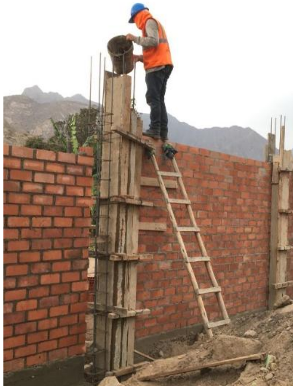
Figura 36. Actividad de vaciado de columnas
