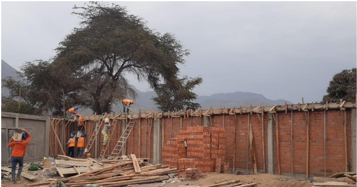
Figura 37. Actividad de encofrado de vigas
