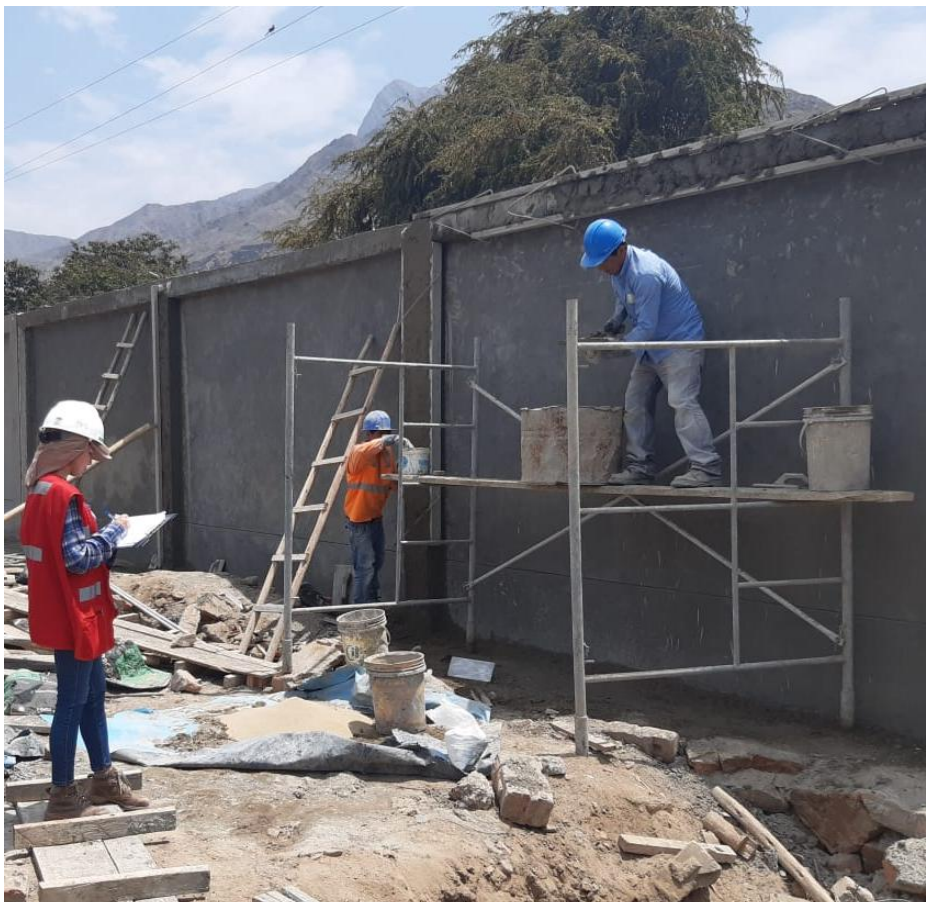
Figura 40. Actividad de tarrajeo de muro, columnas y vigas de cerco perimétrico
