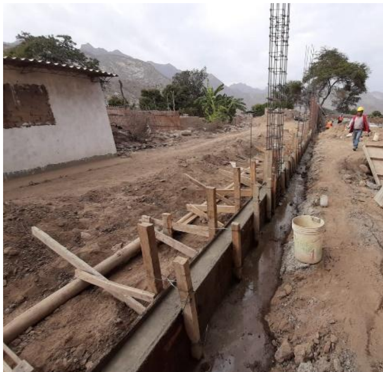
Figura 33. Actividad de vaciado de concreto ciclópeo en cimiento corrido
