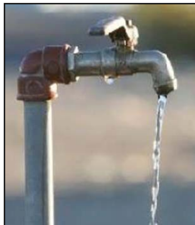
Agua potable y saneamiento
