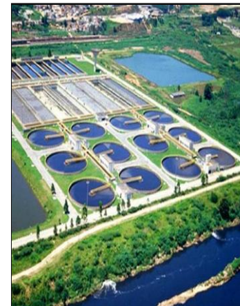
Tratamiento de aguas residuales
