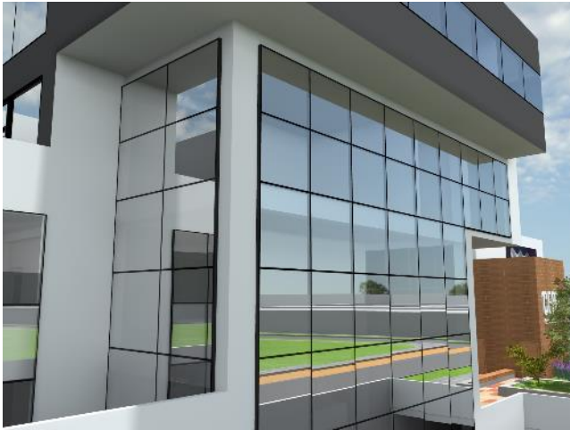
Figura 54 Muro cortina en la fachada principal
