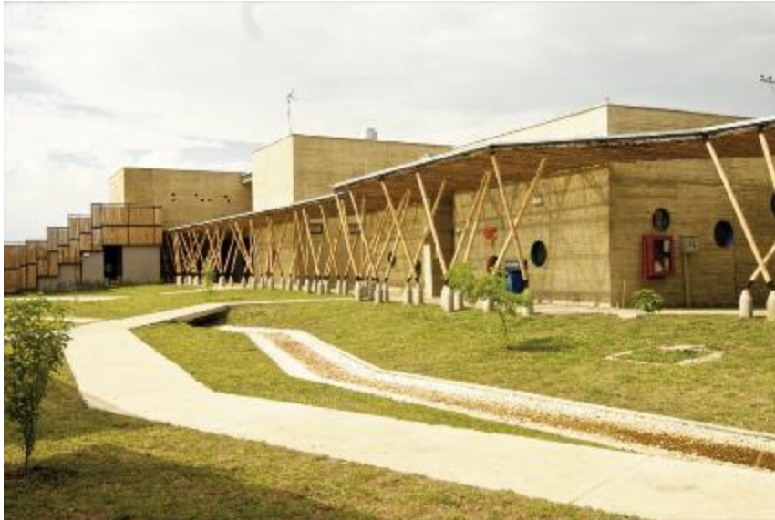
Figura 1: Vista principal del proyecto Centro de Desarrollo Infantil El Guadual
