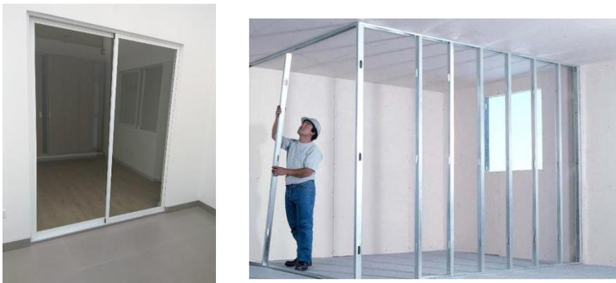
Figura N°46 paneles de drywall y vidrio.
