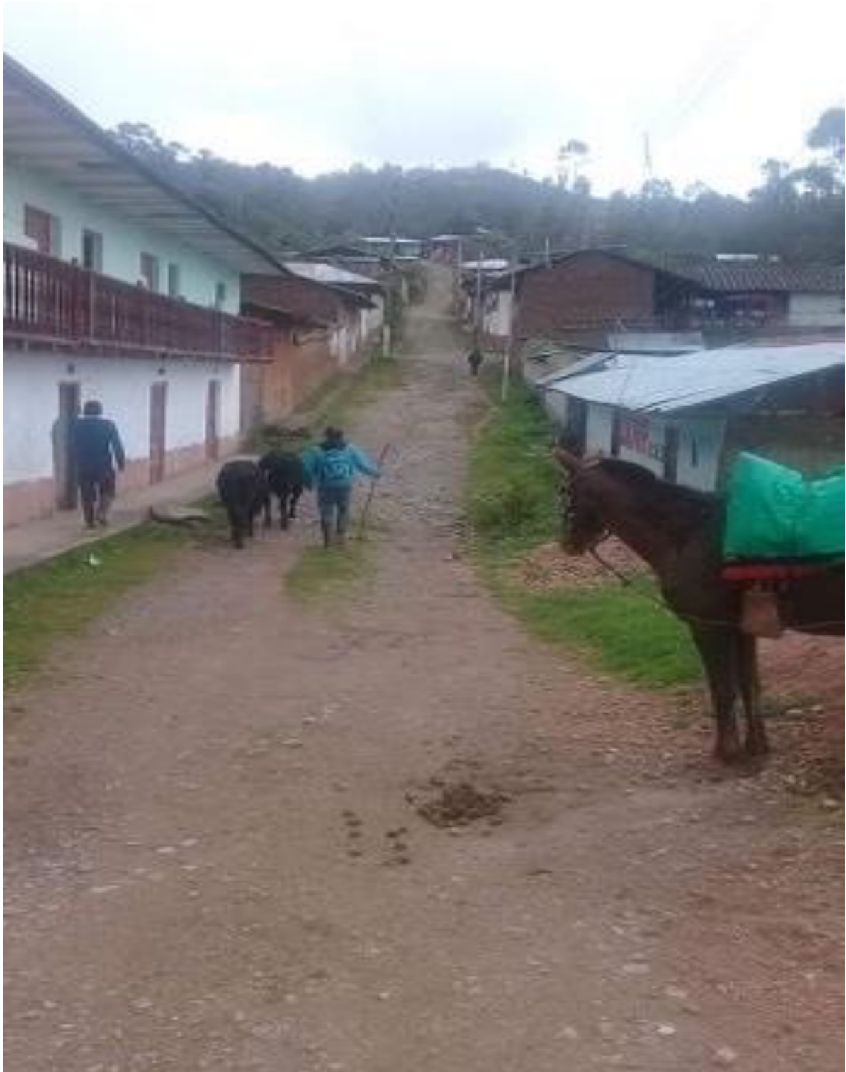
Figura 32: Estado de vías – jiron Olaya
