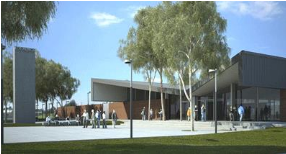
Figura 6: Vista interior del caso n°06
