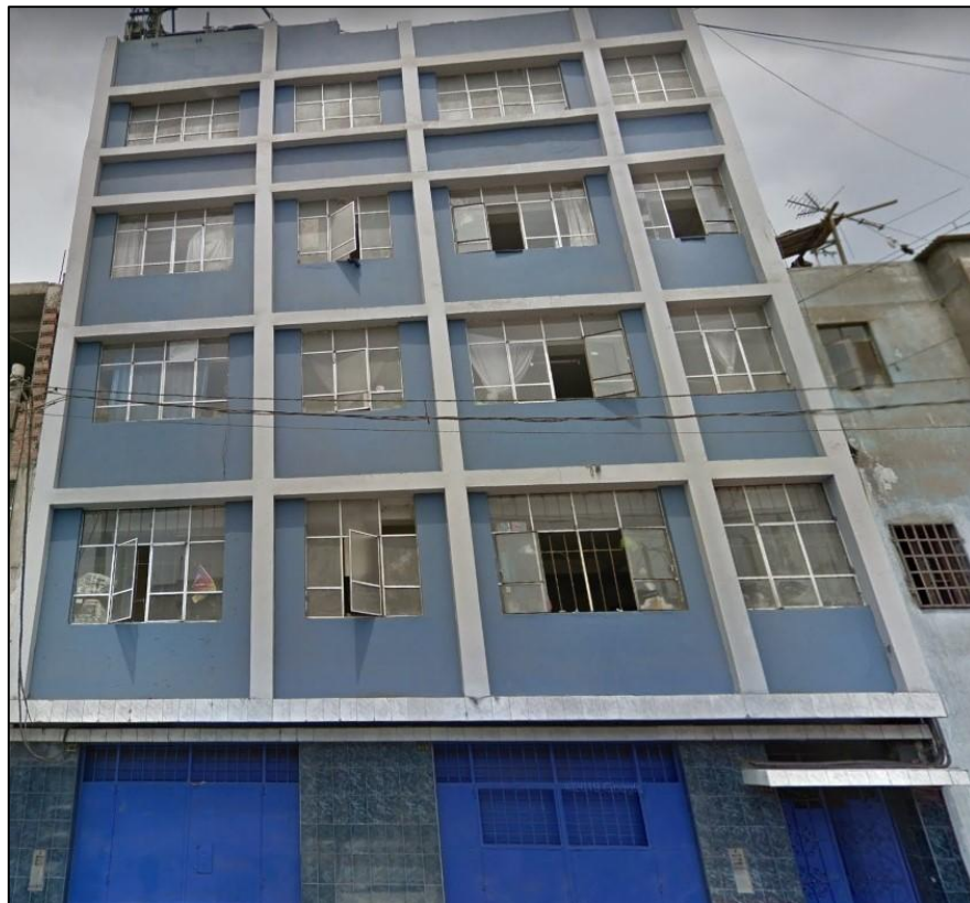
Anexo 1.26 : Fachada de la edificación N° 16
