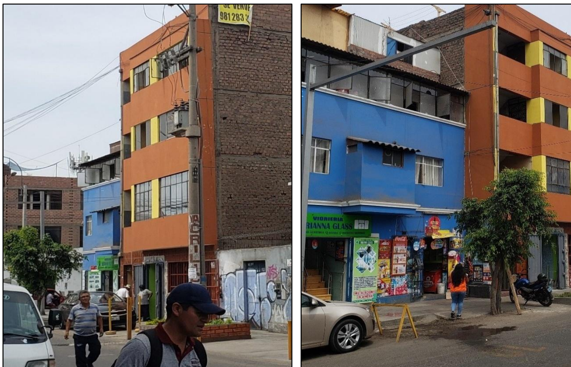
Anexo 1.12 : Verificación de continuidad de muros portantes de albañilería confinada del edificio N° 07
