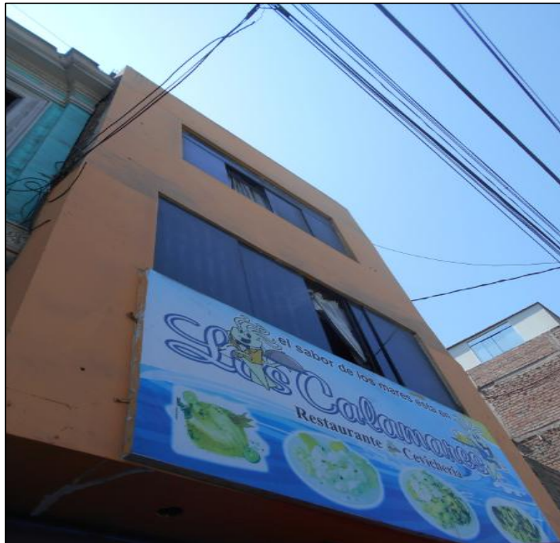
Anexo 1.6 : Fachada de la edificación N° 04
