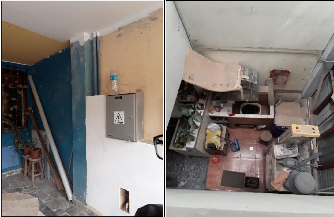
Anexo 1.3 : Se puede apreciar la columna ubicada entre los ejes 3 y 4 además se verifica la continuidad de los muros de albañilería de soga del edificio N° 02
