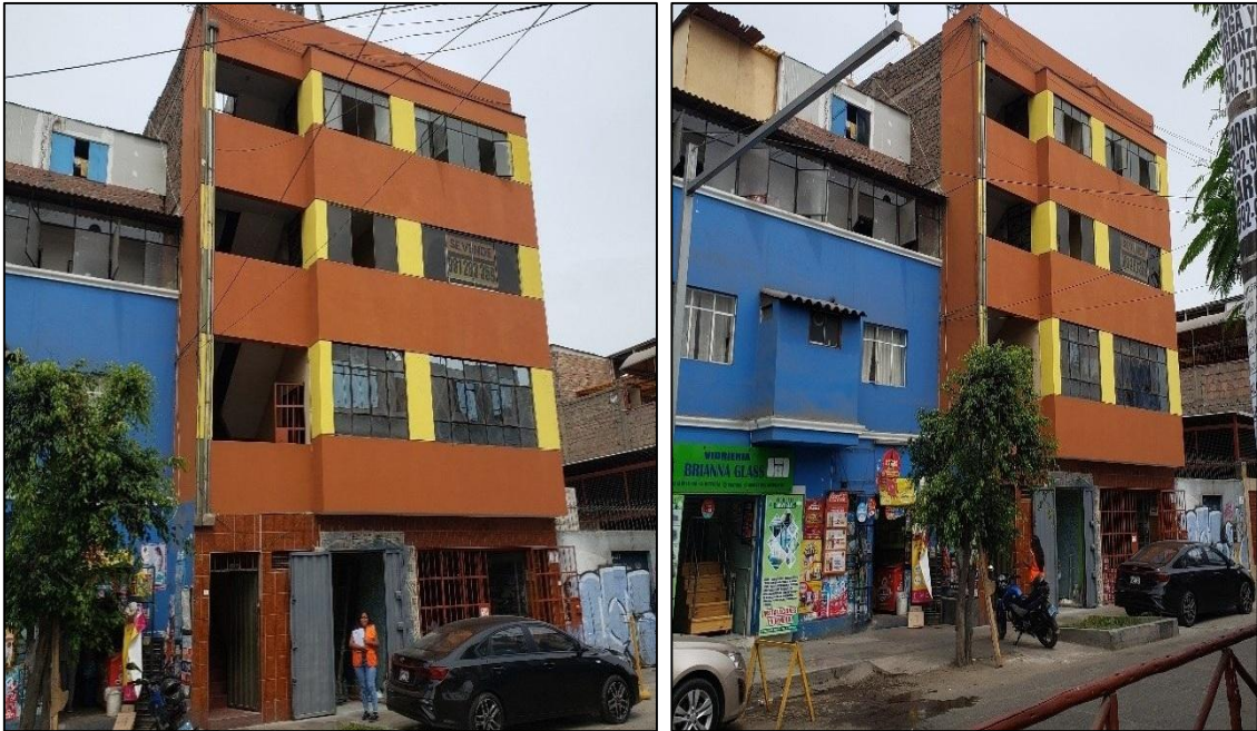
Anexo 1.11 : Fachada de la edificación N° 07
