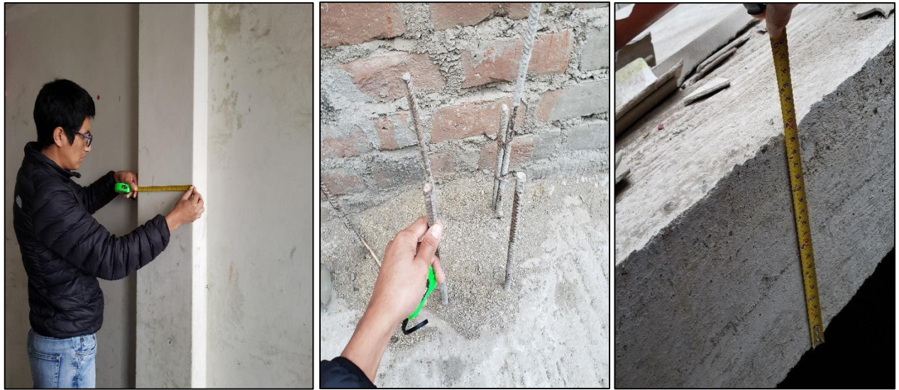
Anexo 1.7 : Toma de medidas de columna de sección de .20x.30m y verificación del peralte de la losa aligerada h=0.20m en la azotea del edificio N° 04
