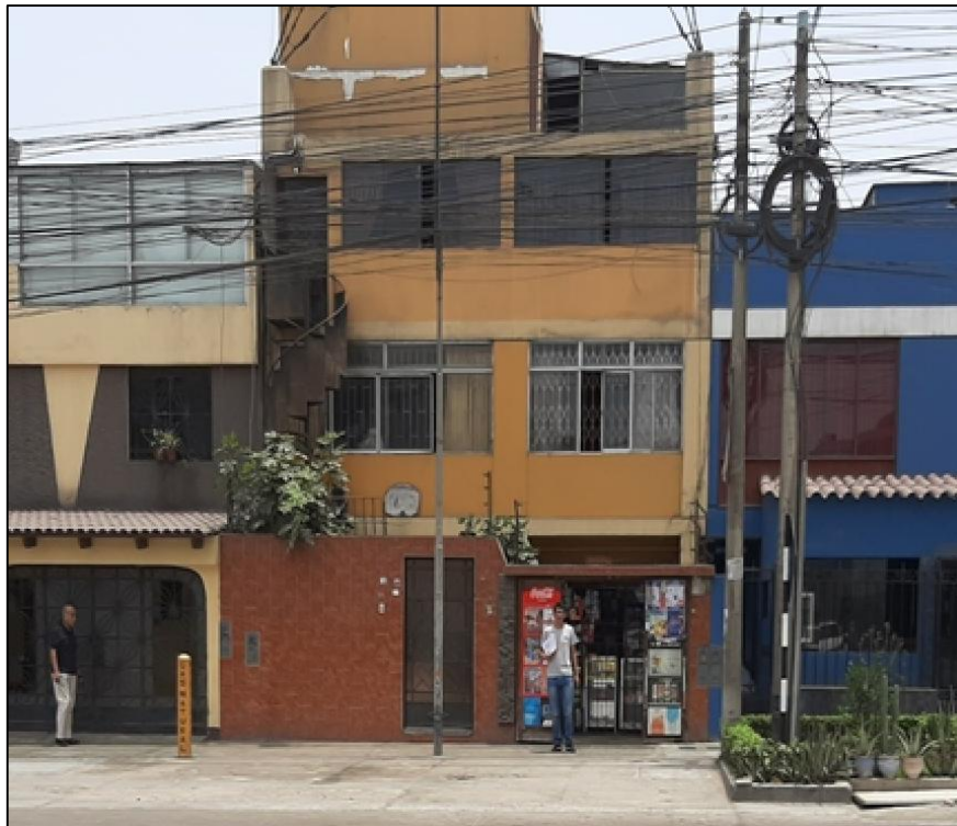
Anexo 1.4 : Fachada de la edificación N° 03
