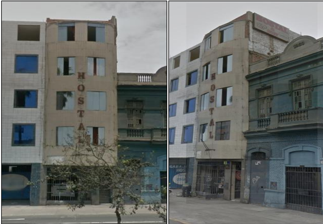
Anexo 1.25 : Fachada de la edificación N° 15
