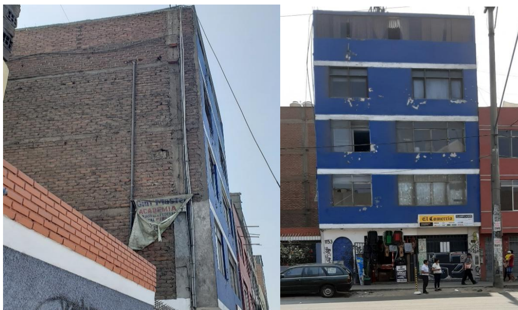
Figura 37: Vista lateral y frontal de la edificación N° 13
