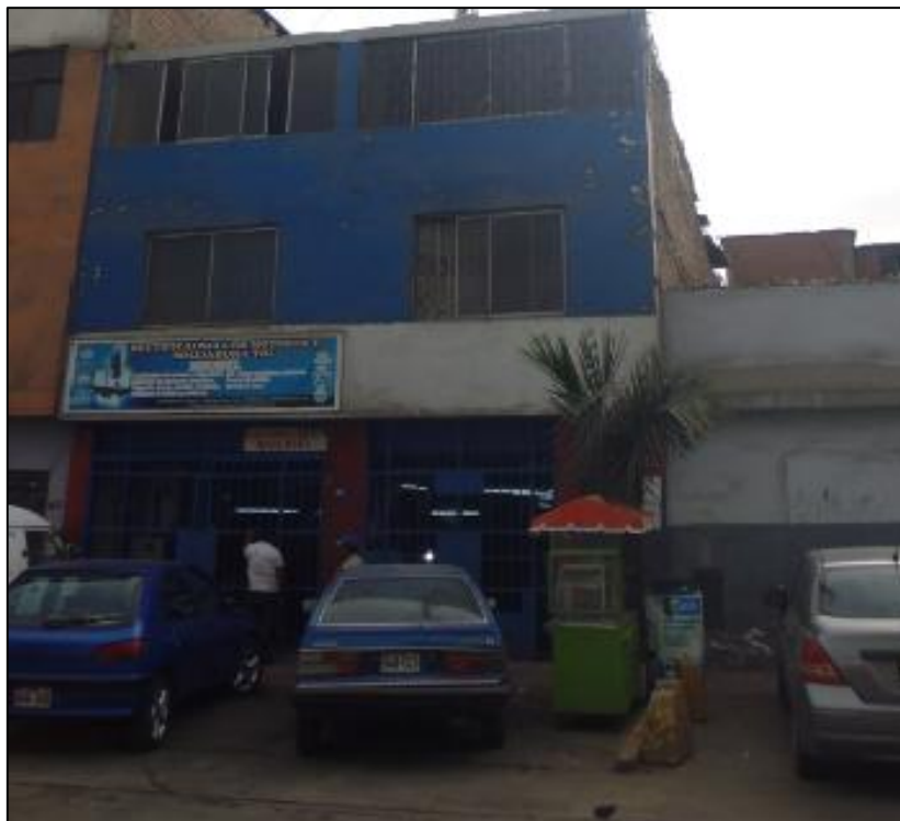
Anexo 1.2 : Fachada de la edificación N° 02
