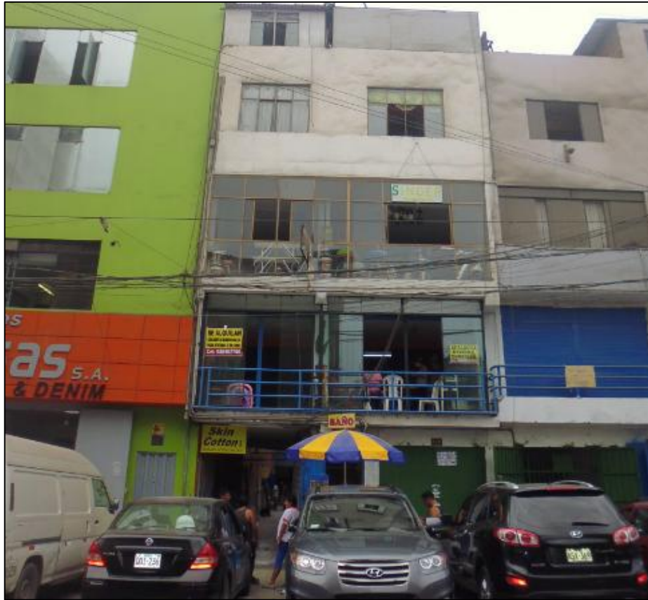
Anexo 1.15 : Fachada de la edificación N° 10
