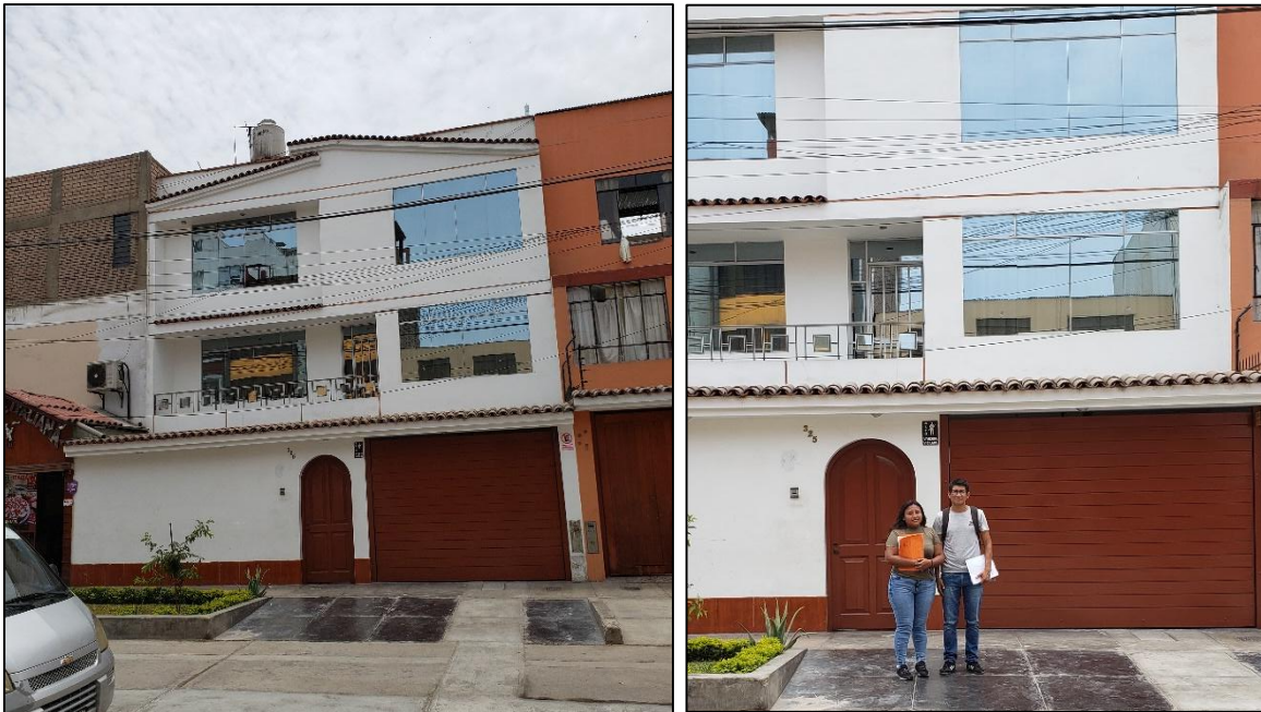
Anexo 1.10 : Fachada de la edificación N° 06
