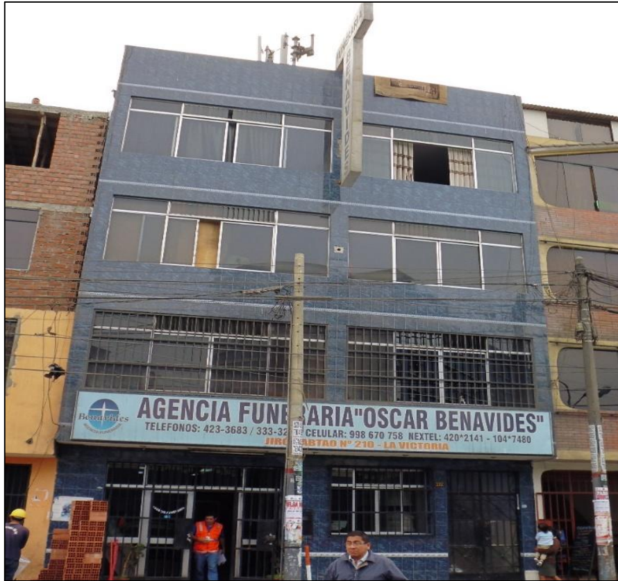
Anexo 1.13 : Fachada de la edificación N° 08
