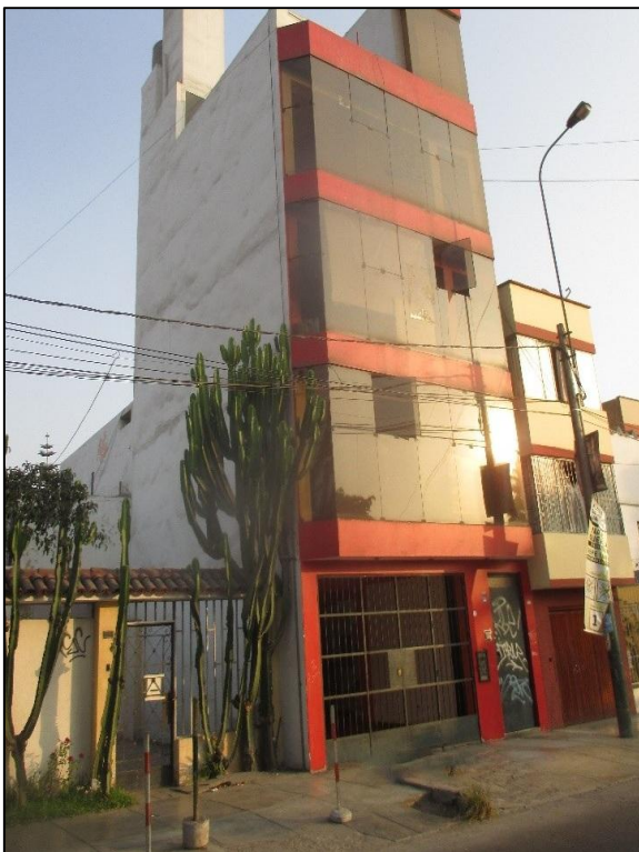
Anexo 1.18 : Fachada de la edificación N° 12
