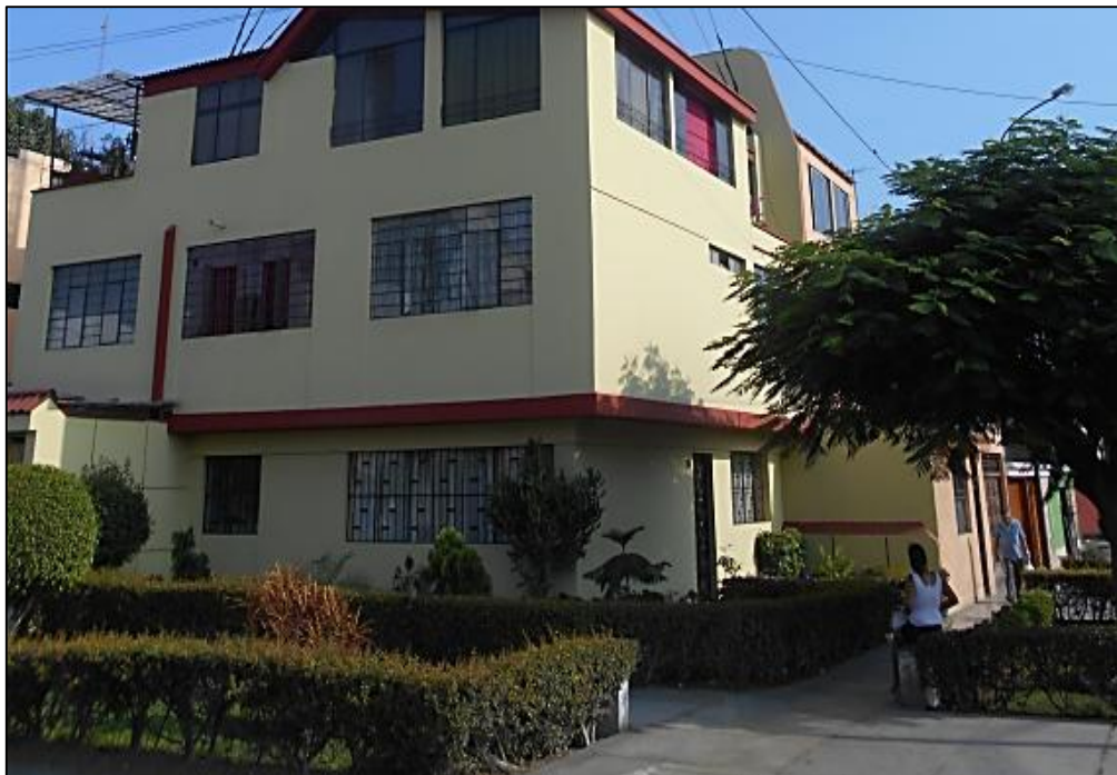
Anexo 1.8 : Vista de la edificación N° 05
