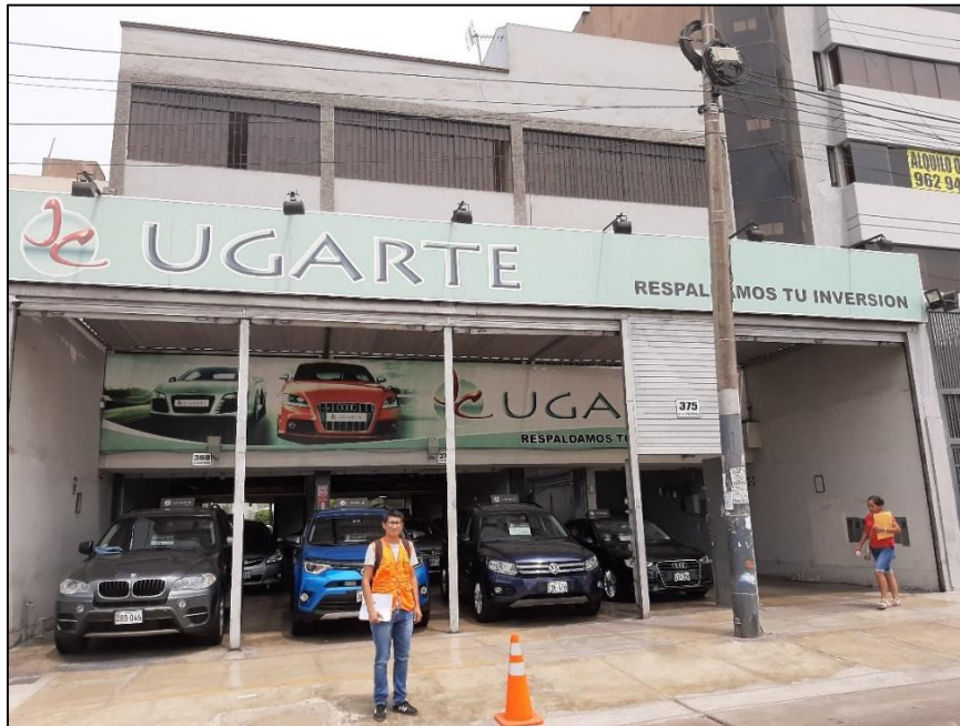
Anexo 1.1 : Fachada de la edificación N° 01
