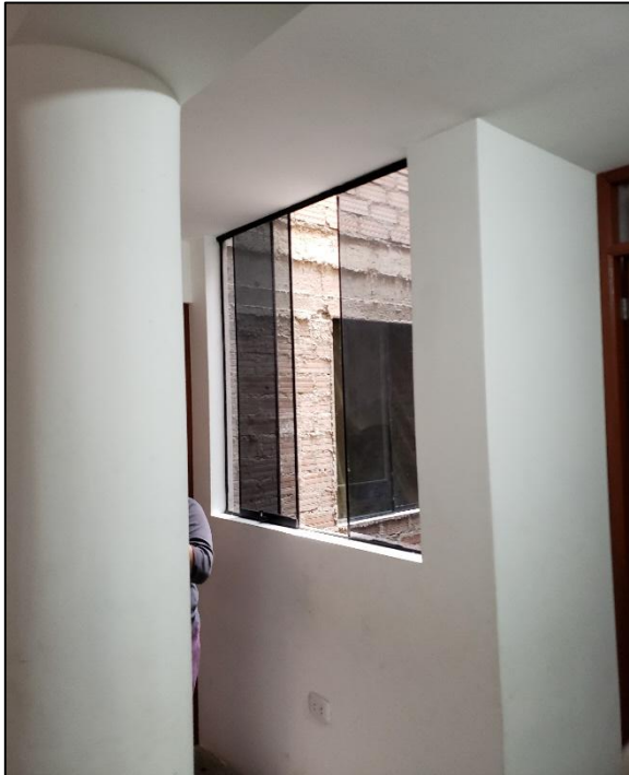
Anexo 1.23 : Fotografías del interior se aprecia la columna de sección circular y la continuidad de los muros de albañilería en el 3er. Piso de la edificación N° 14
