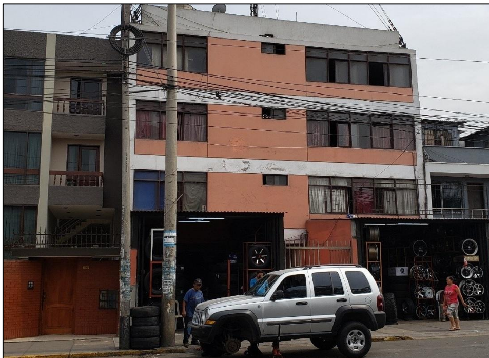
Anexo 1.14 : Fachada de la edificación N° 09
