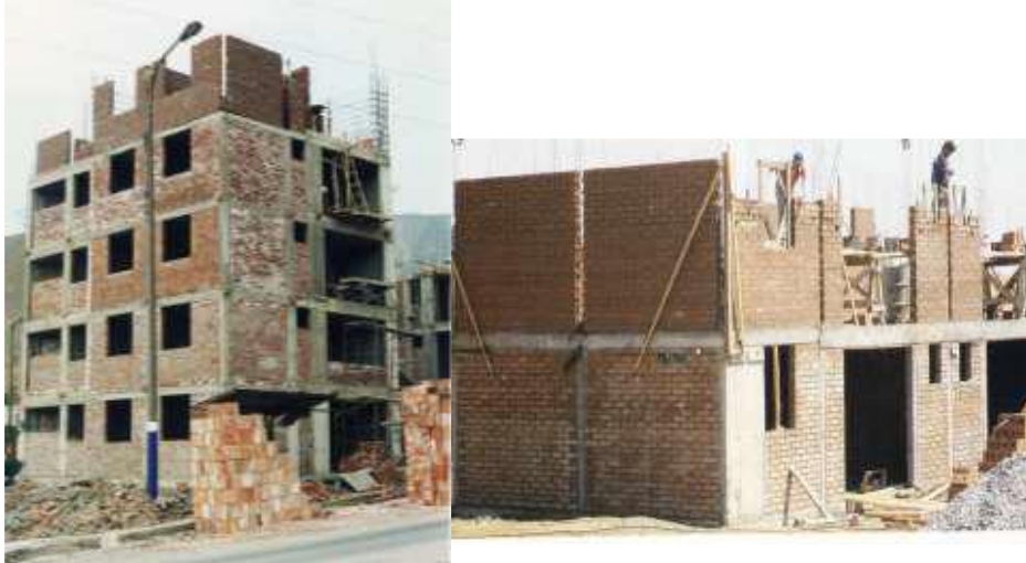
Figura 29 : Edificaciones de albañilería confinada
