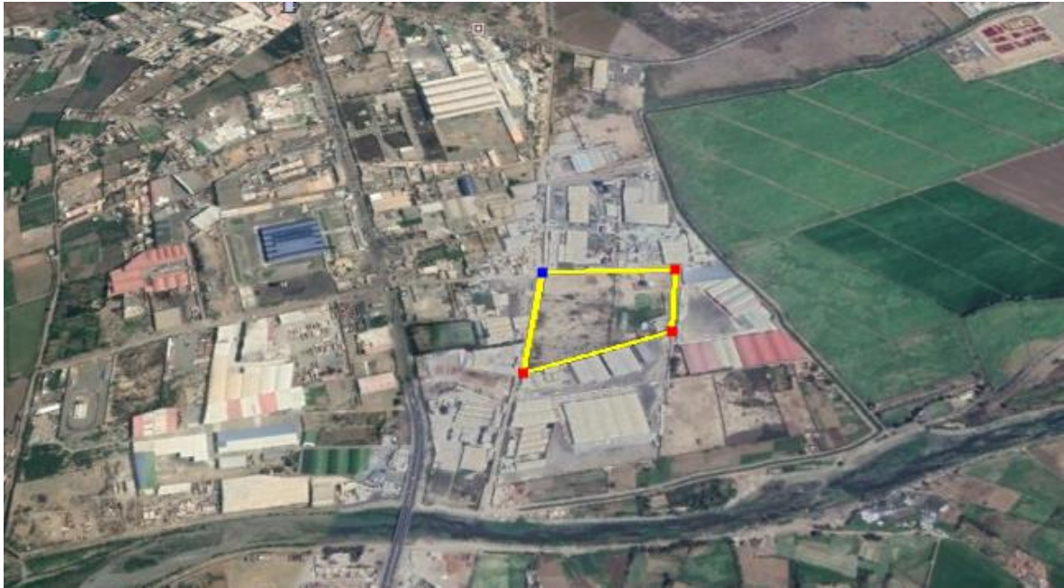
Imagen 08: Vista del terreno
