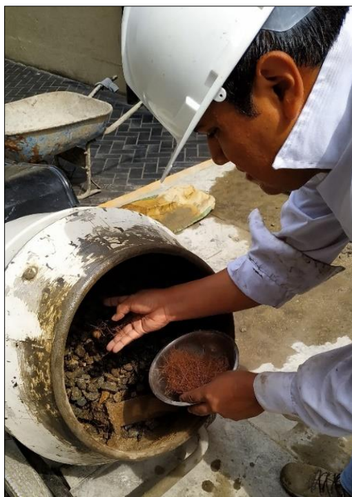
Figura 39. Adición de Fibra de coco en la mezcladora de concreto. Fuente propia.
