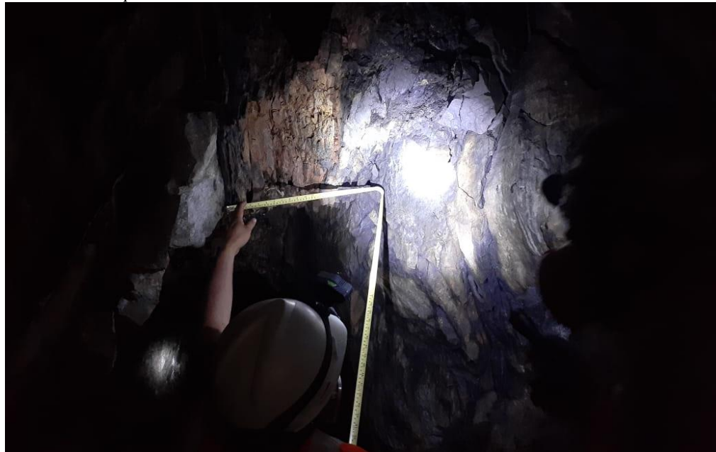
Figura 9 Medición del espaciamiento en estación 1.
