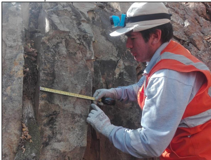
Figura 11 Medición del espaciamiento en estación 3.
