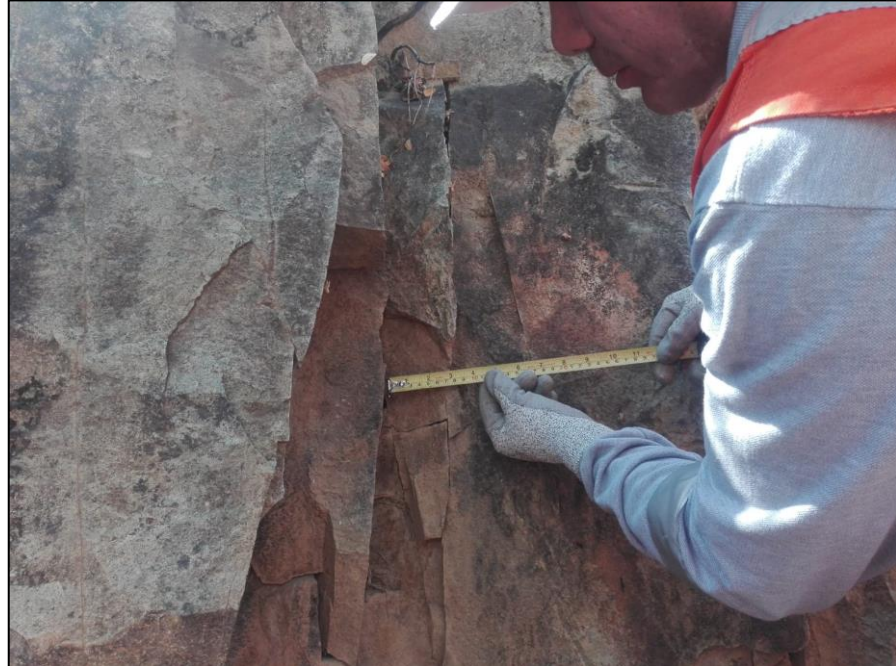
Figura 17 Abertura en estación 3.
