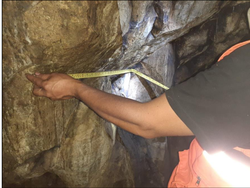
Figura 10 Medición del espaciamiento en estación 2.
