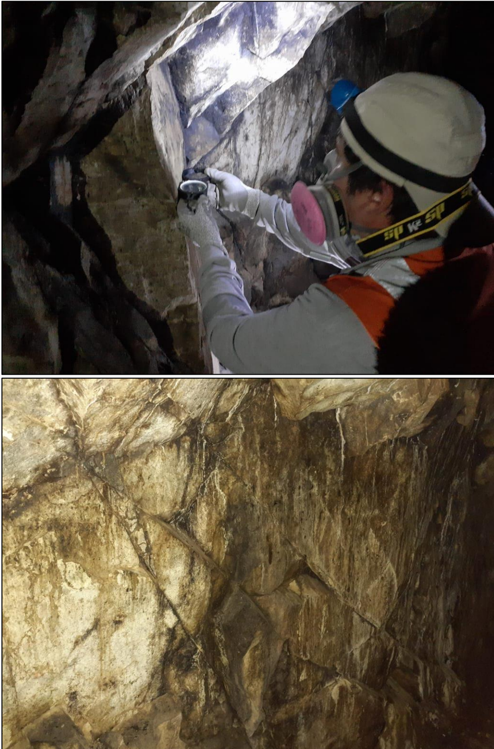
Figura 25: Estación geomecánica del macizo rocoso N°1. donde se observa que la roca andesita está ligeramente alterado debido a los fluidos hidrotermales, presenta Diecinueve fracturas con espaciamiento de las discontinuidades tiene un promedio de 0.16m, ligeramente rugosa, apertura promedio es menor a 0.1mm, relleno es suave con alteración moderada en el macizo rocoso.
