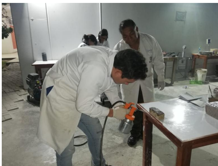
Figura 48: Consolidando los morteros bajo supervisión de un especialista en conservación
