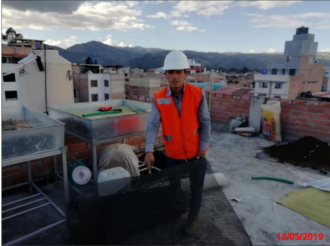
*Fotografía 16: Colocando la capa de drenaje (Geonet) cortado dentro de la bandeja*
