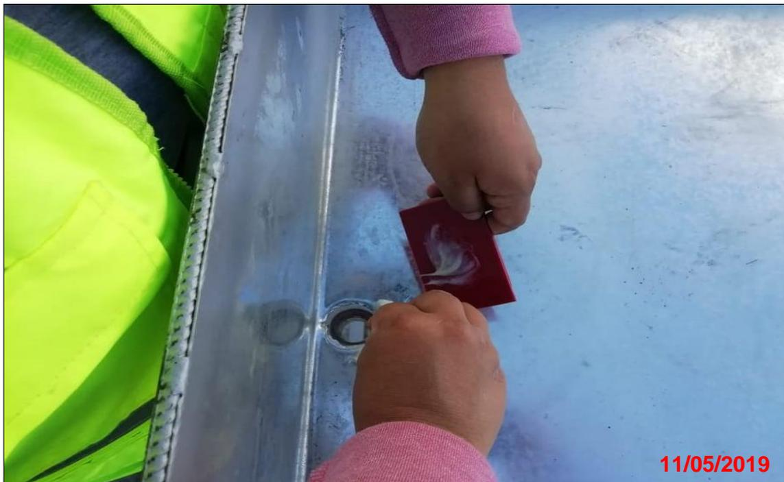
*Fotografía 13: Doblando la Geomembrana para que pueda entrar dentro de la bandeja*
