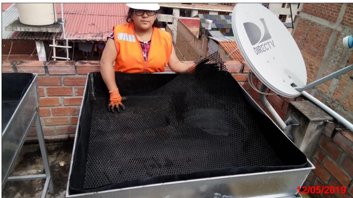
**Paso 5:** Se instaló la capa de filtración, para ello se usó un 1 m<sup>2</sup> de Geotextiles de Polipropileno Punzonado.
