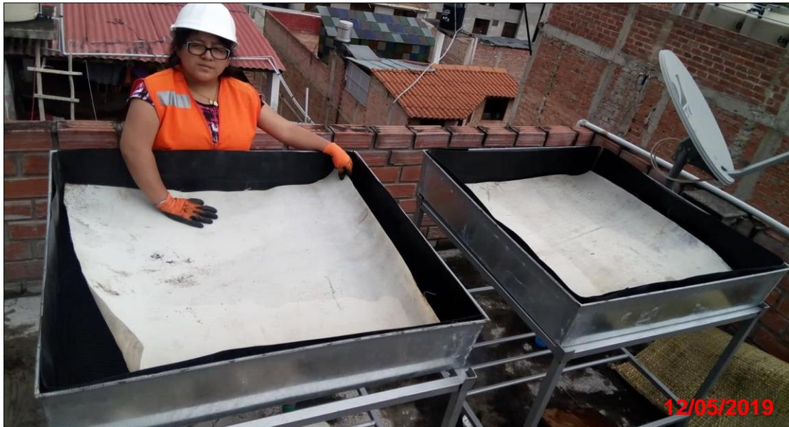
**Paso 6:** En este paso se colocó la capa de sustrato, para el cual fue necesario 50 kg para obtener un espesor de 8 cm.
