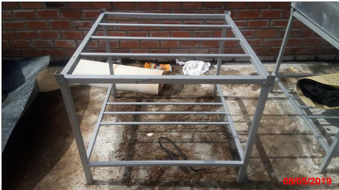
**Paso 2:** Se construyó el soporte base de plancha de acero galvanizado de 1m x 1m; en la cual sostendrá todas las capas.
