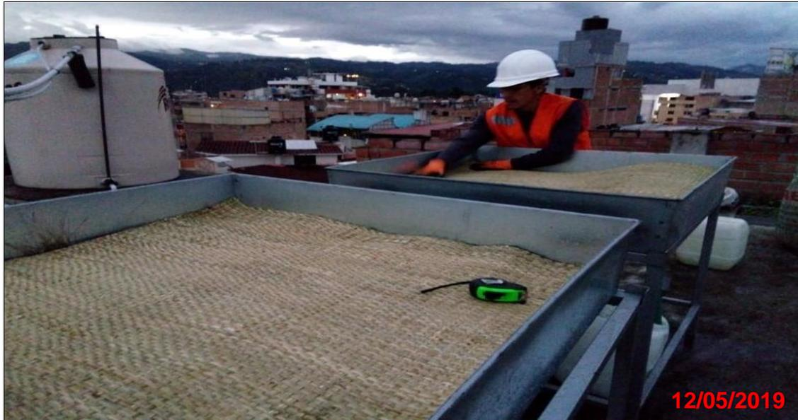
**Paso 6:** En este paso se colocó la capa de sustrato, el cual tubo 20% de material orgánico y 80% de material inorgánico con un espesor de 8 cm.
