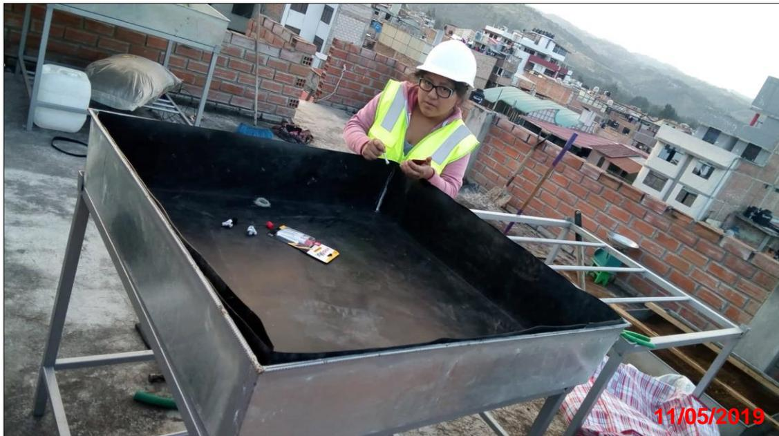
**Paso 4:** Se colocó la capa de drenaje, para ello se usó un 1 m<sup>2</sup> de Geonet.
