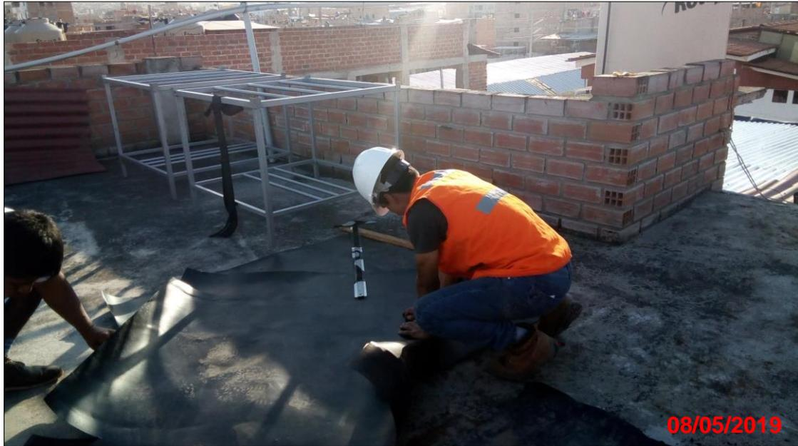
**Paso 3:** Se colocó la membrana impermeable (Geomembrana) en todo el soporte base, teniendo en cuenta que esta capa es la primera y debió cubrir hasta la capa de vegetación.
