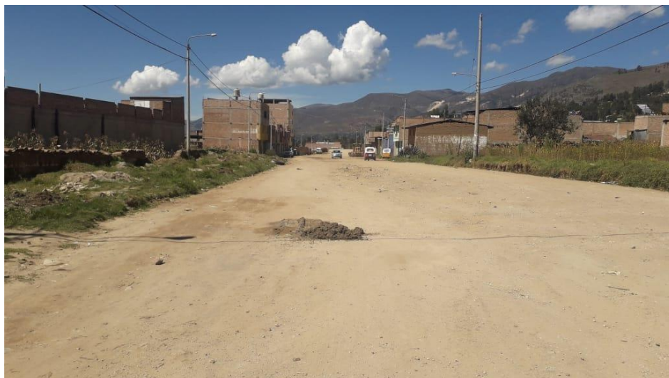
Figura 33. Calle Industrial que no existe acera.
