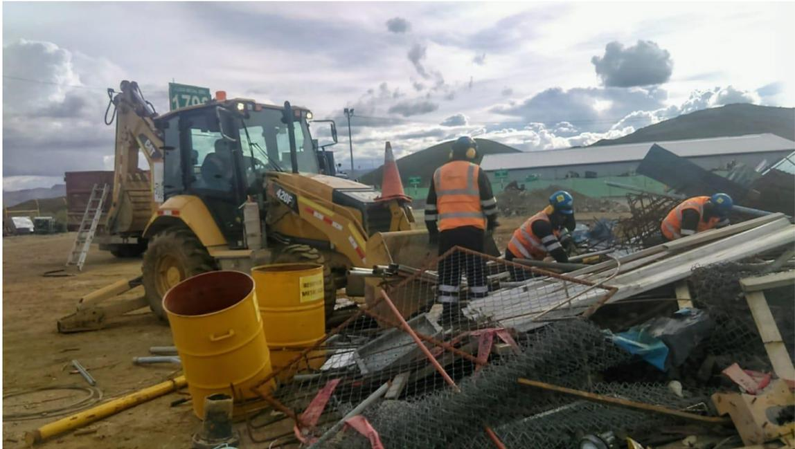
**Figura 13:** *Segregación de residuos metálicos.*
