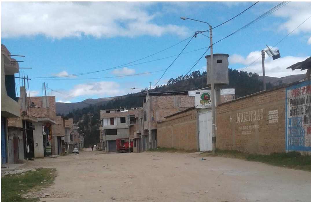
Figura 17: Fachada Multitrac S.A
