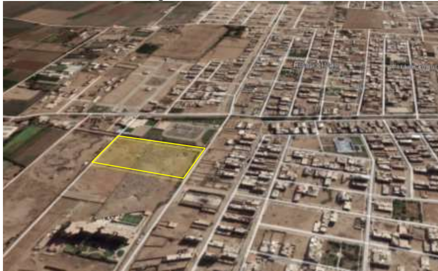
Figura N°43: Vista de Terreno N° 03
