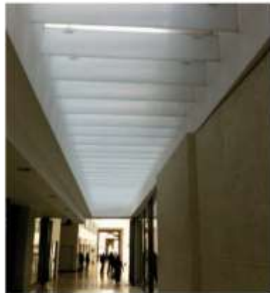
Imagen N°54: Dispositivos de protección solar interior en comedor de luz, galería comercial, Santiago.
