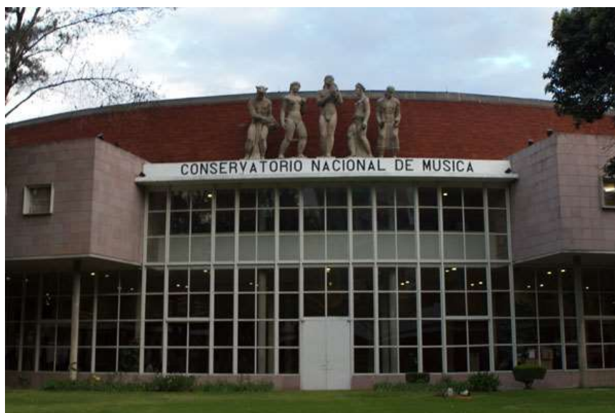
Figura N° 09: Vista externa del Conservatorio Nacional de Música de Polanco
