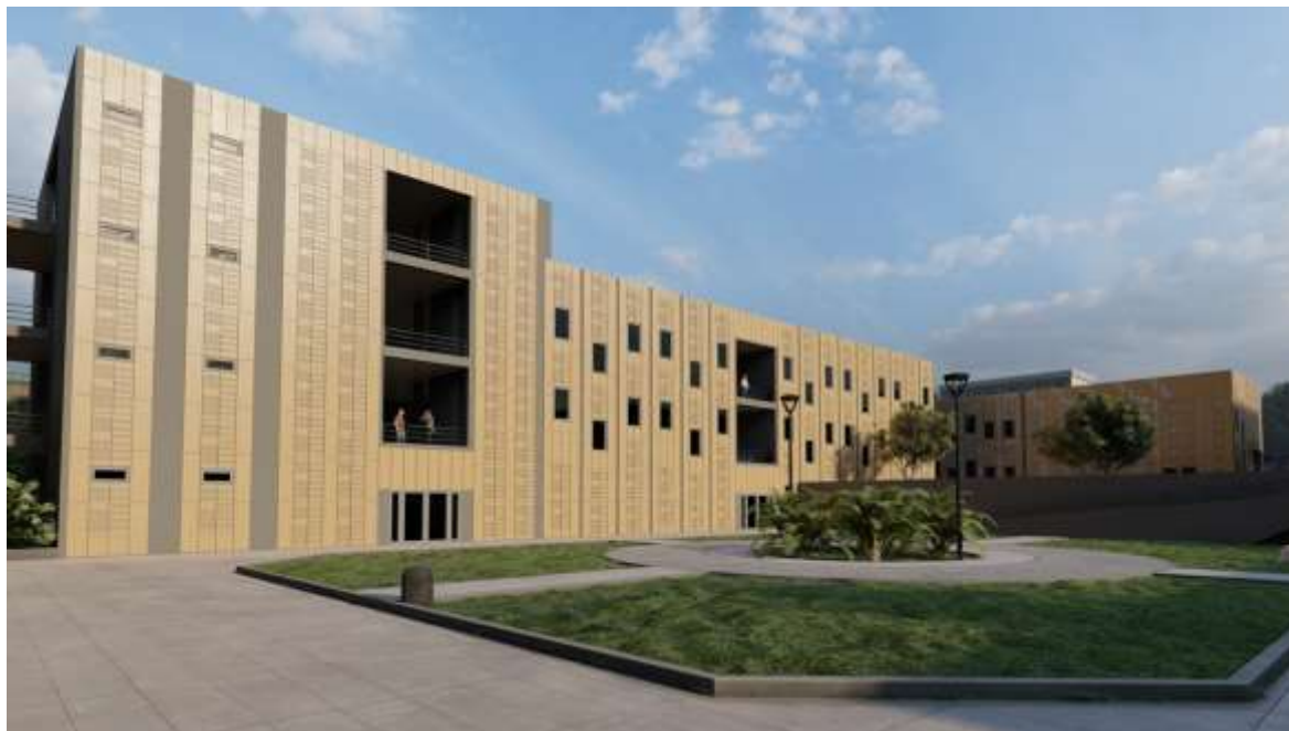
Figura nº 38: Vista de la zona pedagógica (Bloque B) y administrativa
