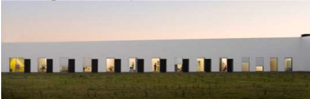
Figura N° 07: Vista interna y externa de la Escuela de Música de Lisboa
