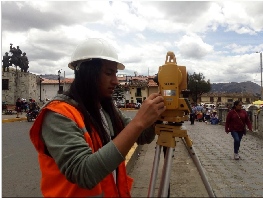
Fotografía 3 Estación El Iglesia San Sebastián - La Recoleta
