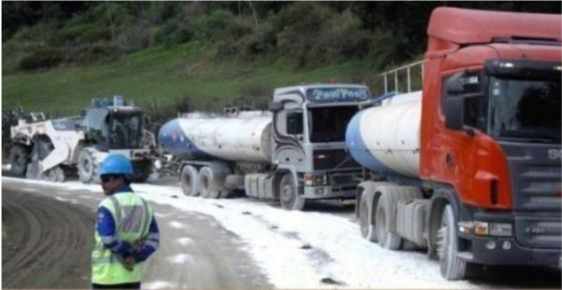
Carretera interoceánica Tramo: Nazca-Cusco- Urcos
