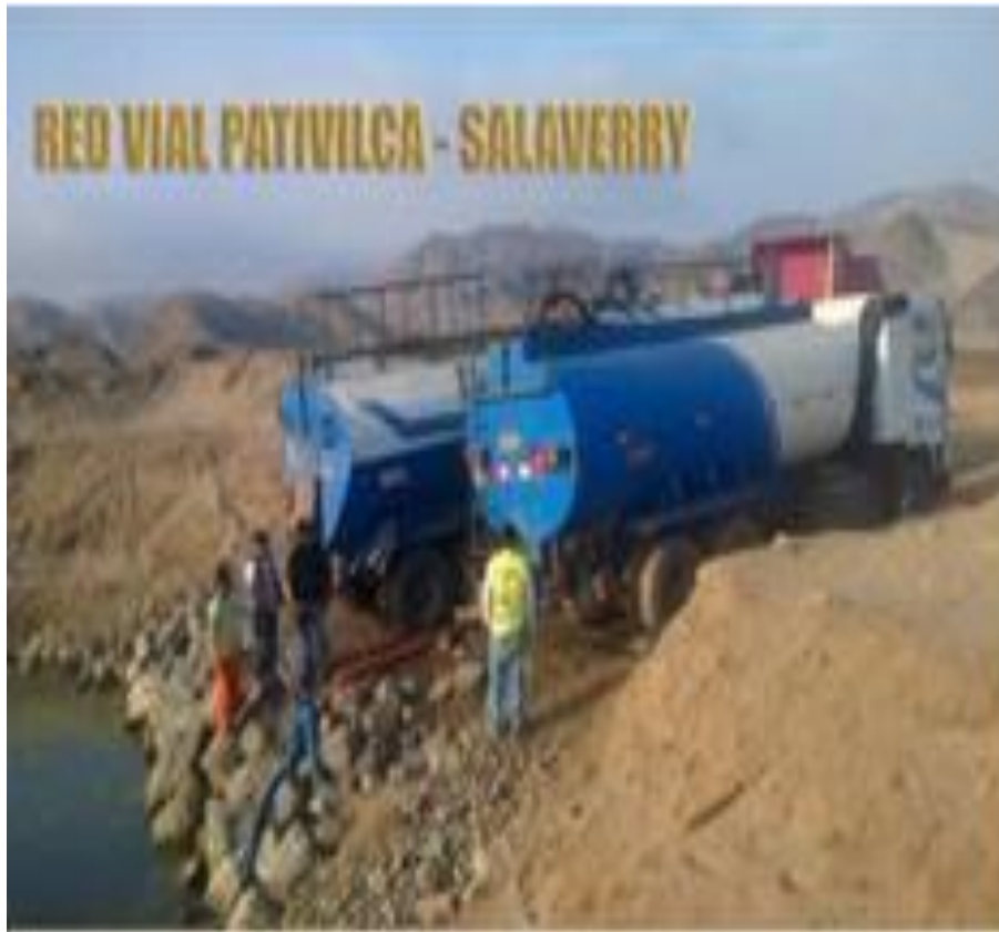
Succión de aguas contaminadas
