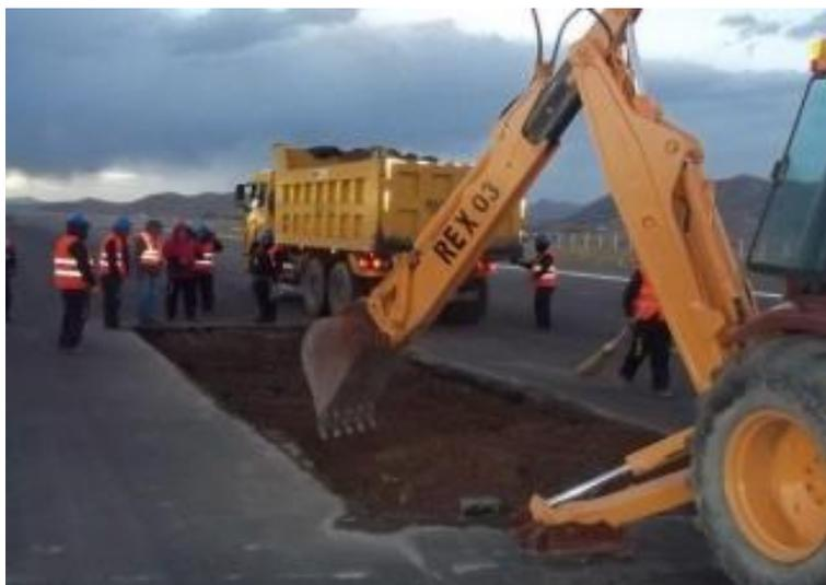
**Figura 15** Parchado con mezcla asfáltica en caliente en la Pista de Aterrizaje del AIRB
