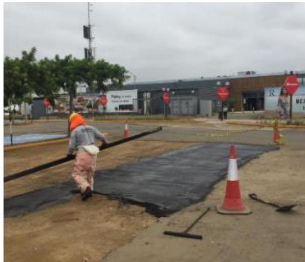
**Figura 11** Aplicación de Slurry en estacionamiento, Boulevard de Asia
