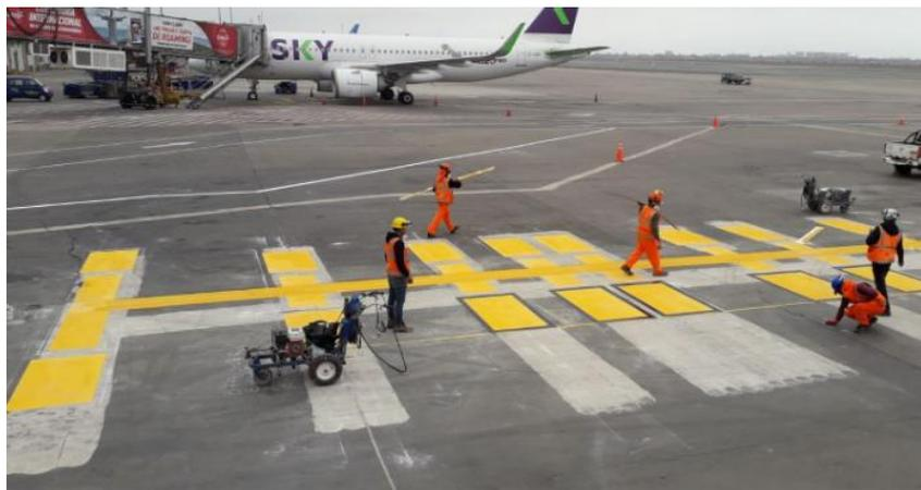
**Figura 9** Restitución de Señalización Horizontal
