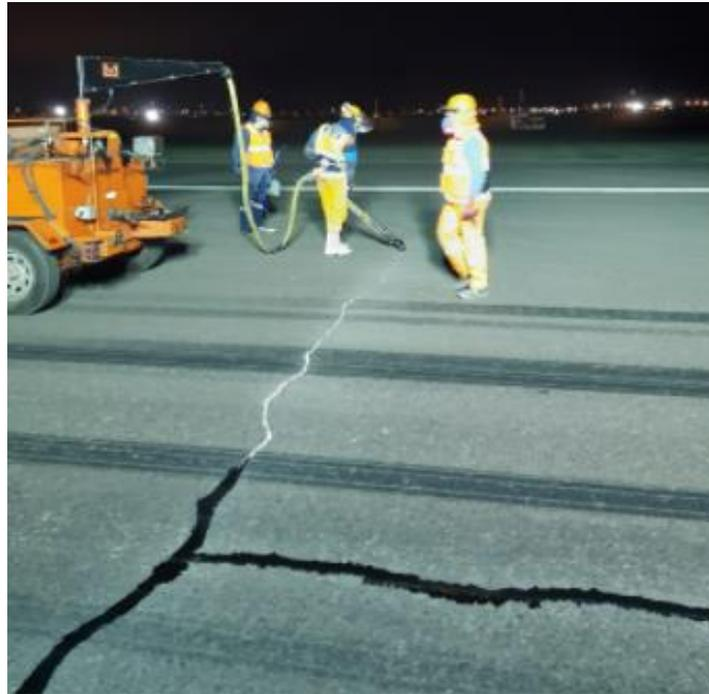
**Figura 31.** Actividad: Aplicación de sello en caliente, tipo reservorio
