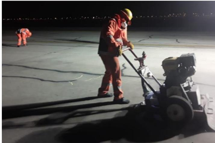
**Figura 28.** Actividad: Corte de fisuras y grietas con equipo
