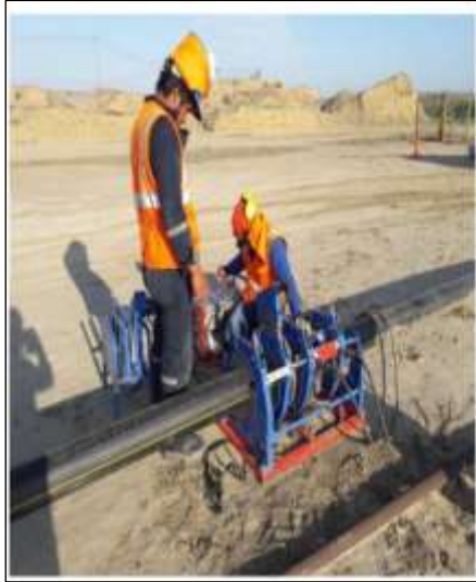
Figura 6. Construcción de ductos con tubería HDPE – Cliente GMP Fuente Constructora Alfaro Ingenieros E.I.R.L.
