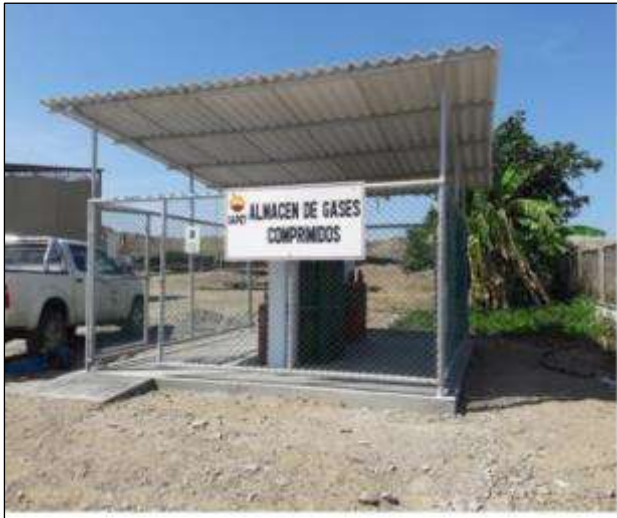
Figura 4. Construcción almacén de gases – Cliente SAPET Fuente: Constructora Alfaro Ingenieros E.I.R.L
