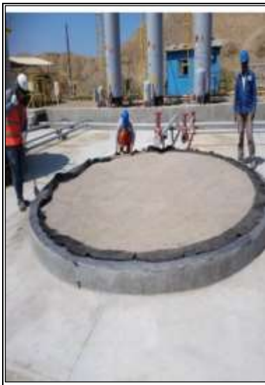
Figura 3. Construcción de anillo de concreto – Cliente SAPET Fuente: Constructora Alfaro Ingenieros E.I.R.L.
