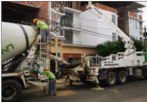
Figura 5. Construcción de Vivienda Multifamiliar Fuente: Constructora Alfaro Ingenieros E.I.R.L
