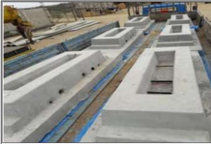
Figura 2. Construcción Vigas Tipo B para unidades de Bombeo – Cliente SAPET Fuente: Constructora Alfaro Ingenieros E.I.R.L.
