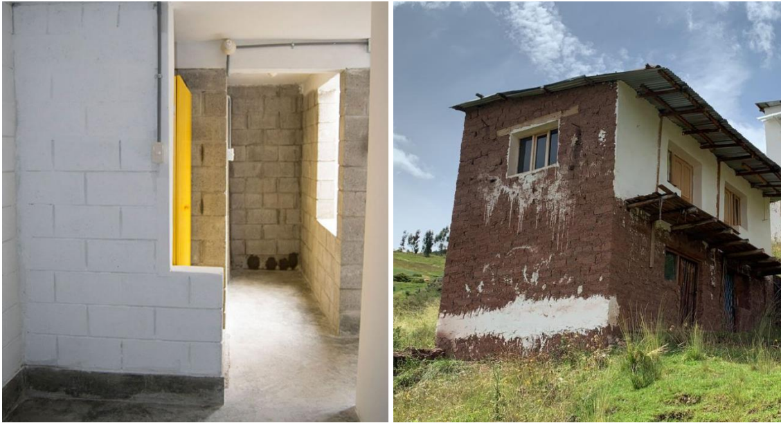
Figura 3. Construcción de paredes e instalaciones en vivienda autosostenible, a partir de la iniciativa de la Embajada Británica (izquierda), y a partir del uso de adobe de la zona en la construcción (derecha)
