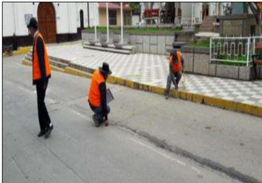
Figura 6: Progresivas Km 52+860-Km 52+830 (Ancho de calzada: 7.10m).
