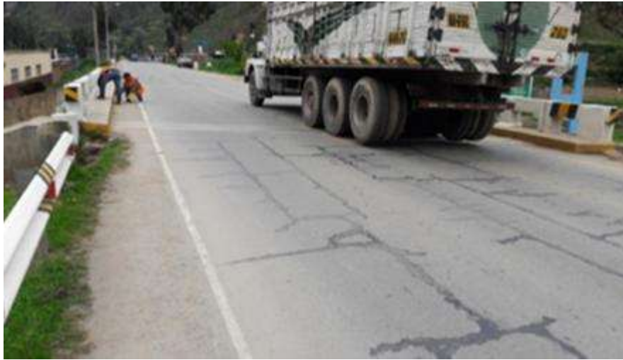
Figura 13: Progresivas Km 53+570-Km 55+332.15 (Ancho de calzada: 6.60m).
