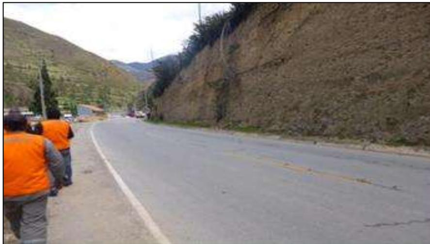
Figura 8: Progresivas Km 51+700-Km 52+350 (Ancho de calzada: 6.40m)
