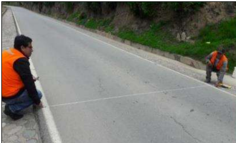
Figura 9: Progresivas Km 52+420-Km 52+760 (Ancho de calzada: 3.85m).
