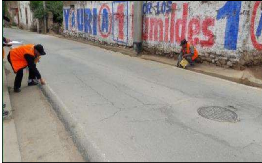
Figura 11: Progresivas Km 53+090-Km 53+ 120 (Ancho de calzada: 4.40m).
