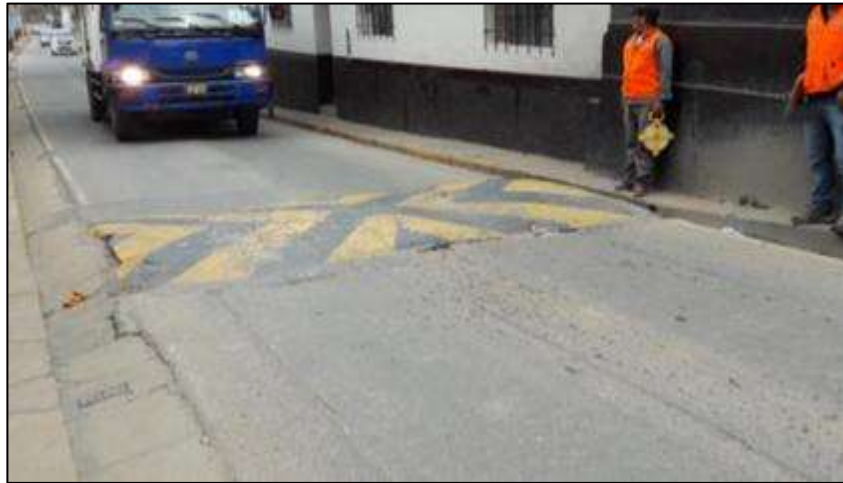
Figura 5: Progresivas Km 52+896-Km 52+860 (Ancho de calzada: 4.00m).
