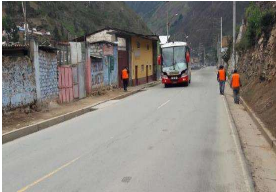
Figura 12: Progresivas Km 53+210-Km 53+570 (Ancho de calzada: 6.40m).
