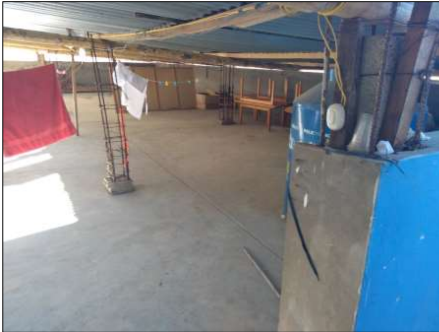
Figura 28. Se puede apreciar las mechas para las columnas (Fuente: propia)
