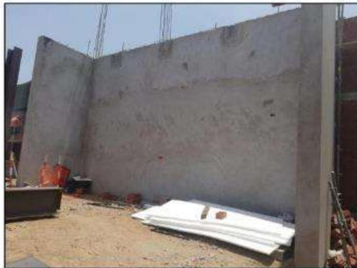
Foto N° 04: Se aprecia el tarrajeo de placa en el bloque A.
