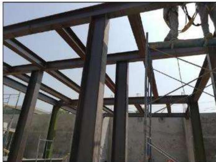
Foto N° 02: Se aprecia la instalación de columnas y vigas metálicas en el bloque A.
