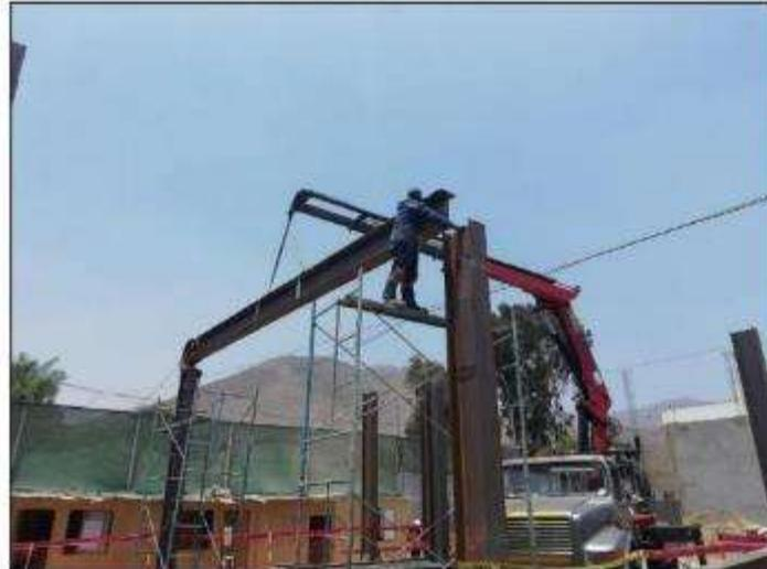
Foto N° 01: Se aprecia la instalación de columnas y vigas metálicas en el bloque A.
