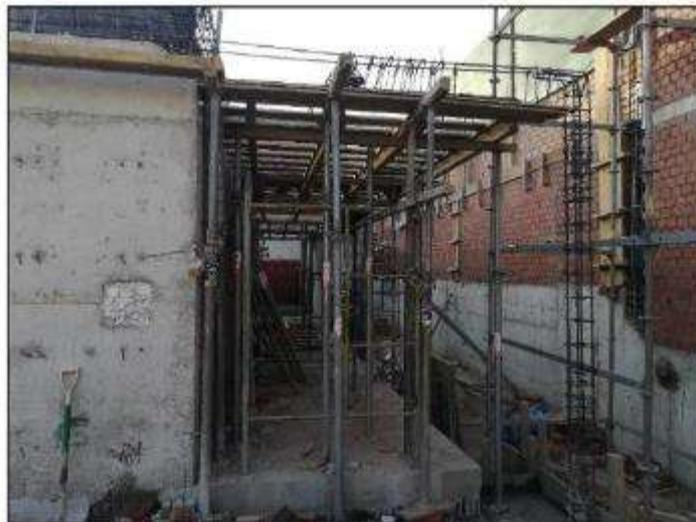
Foto N° 08: Se aprecia el encofrado de losa primer nivel bloque B.
