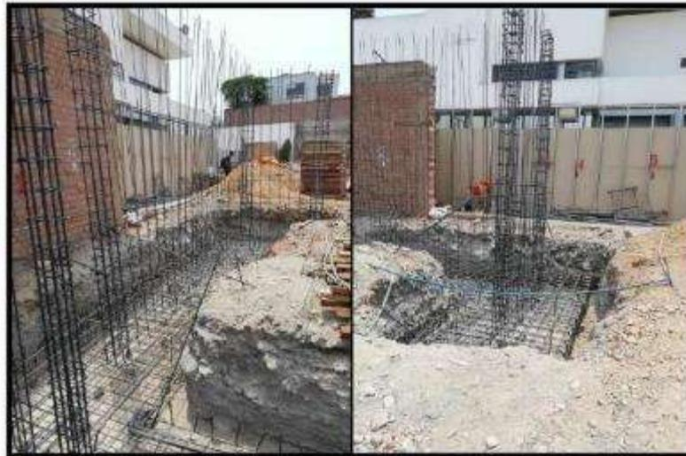
Foto N° 10: Se aprecia el colocado de acero para la cimentación y la placa 2 en el bloque A.
