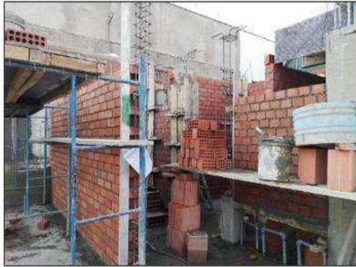
Foto N° 07: Se aprecia el asentamiento de ladrillos en el bloque B.
