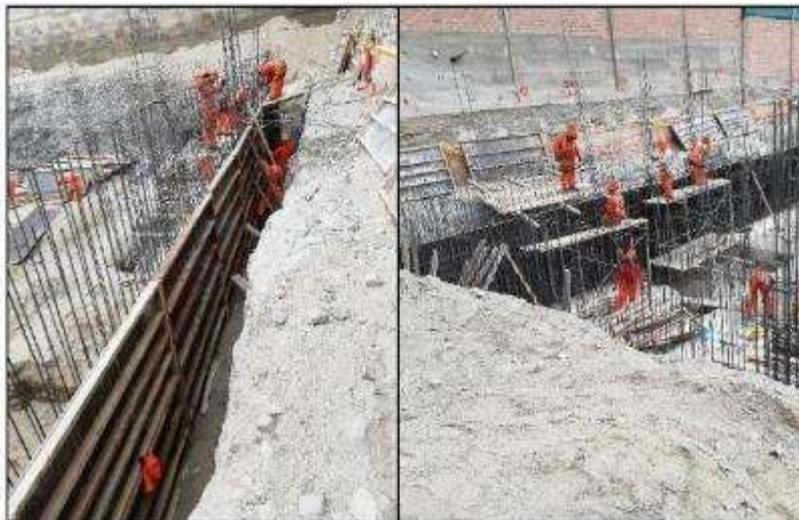
FOTO N° 06: Se aprecia el encofrado para muros en sótano.
