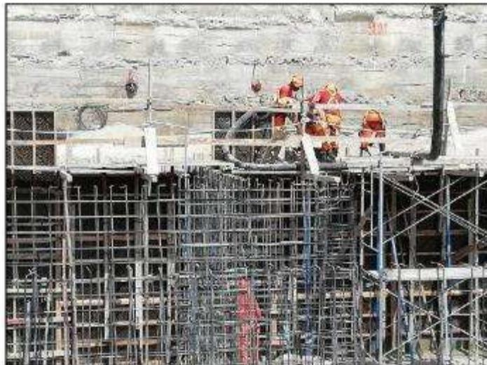
Foto N° 04: Se aprecia el vaciado de muros en sótano.
