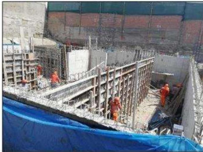
Foto N° 03: Se aprecia el encofrado de muros en sótano.
