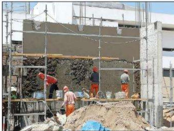
Foto N° 02: Se aprecia el tarrajeo de placa en el bloque A.
