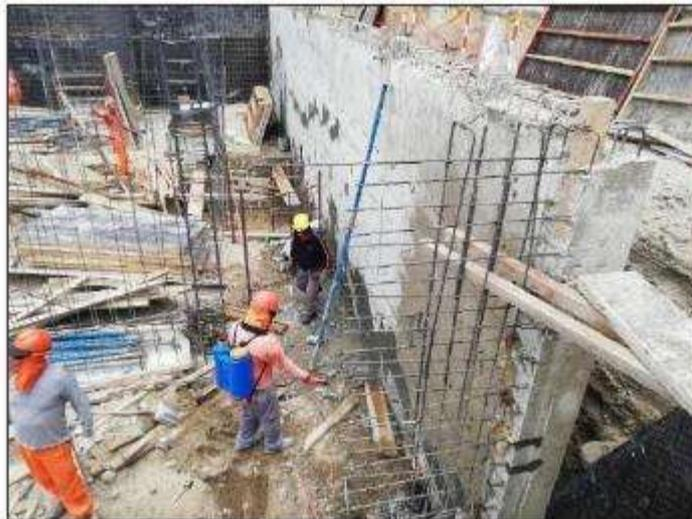
FOTO N° 08: Se aprecia el desencofrado y curado químico del muro en sótano.
