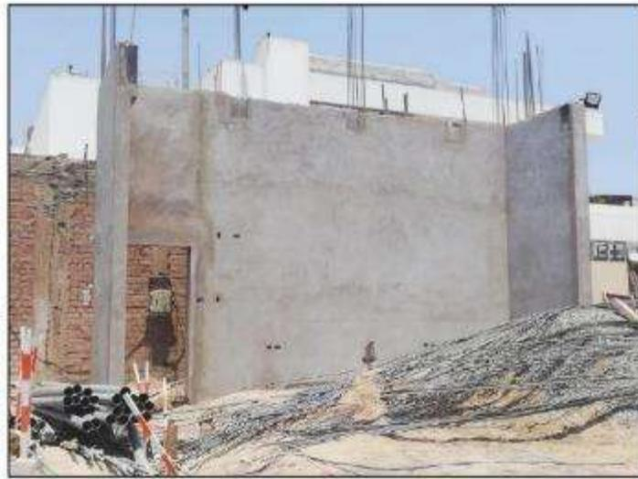
Foto N° 03: Se aprecia el tarrajeo de placa en el bloque A.
