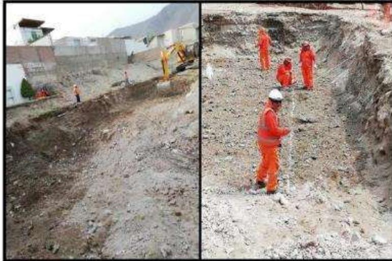
Foto N° 01: Se aprecia la excavación para la piscina y el comienzo de los trazos de ejes realizados por el topógrafo.
