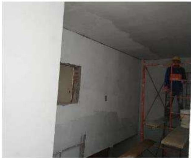
Foto N° 38: Se aprecia el empastado de paredes.
