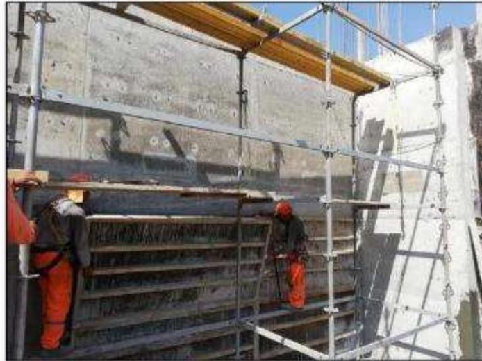
Foto N° 01: Se aprecia el desencofrado de placa en el bloque A.
