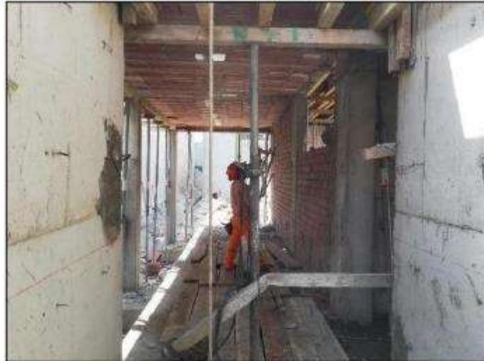
Foto N° 01: Se aprecia el desencofrado de losa primer nivel Zona Cavas.
