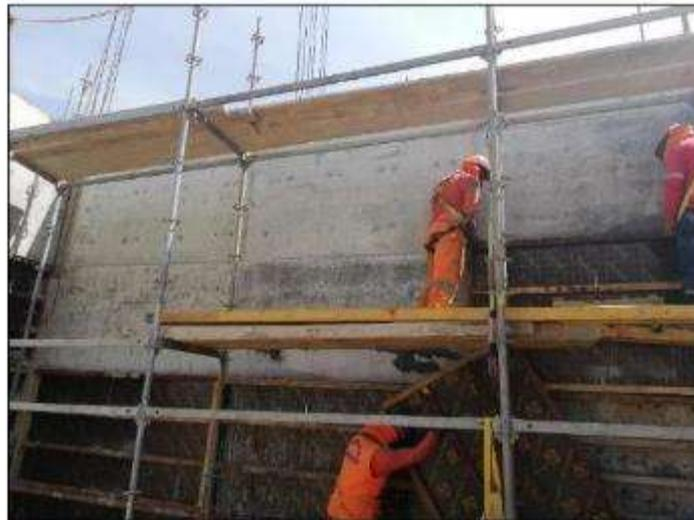
Foto N° 14: Se aprecia el desencofrado de la placa 1, bloque A.
