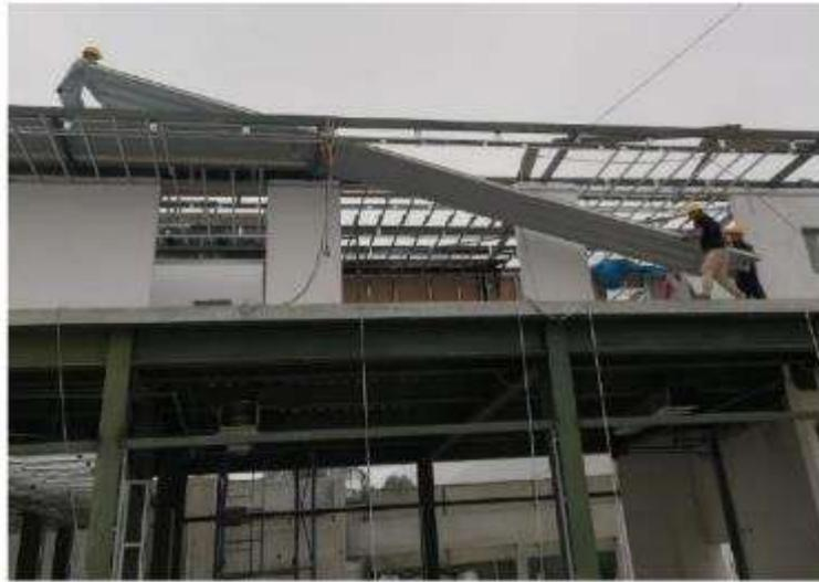
**Foto 19: Instalación de panel termoaislante TAT 1060.**
