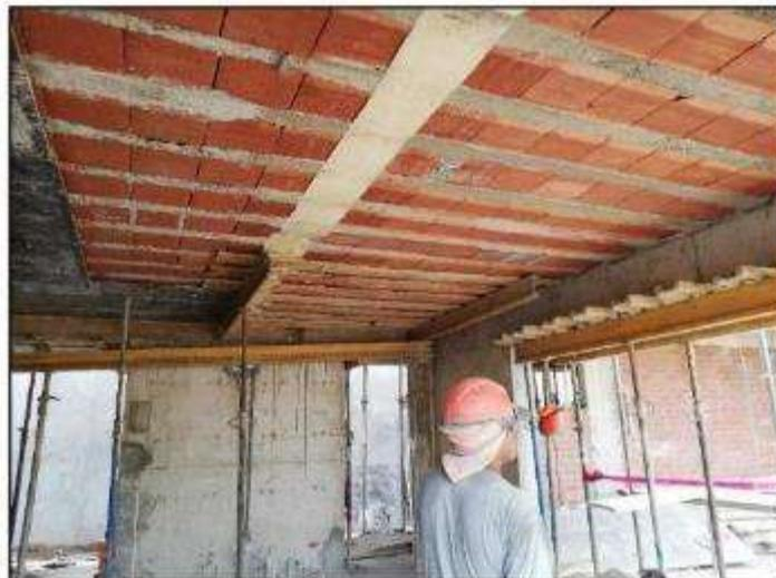
Foto N° 02: Se aprecia el desencofrado de losa primer nivel Zona Cavas.
