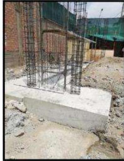
Foto N° 08: Se aprecia el vaciado de la cimentación de la placa 1 en el bloque A.
