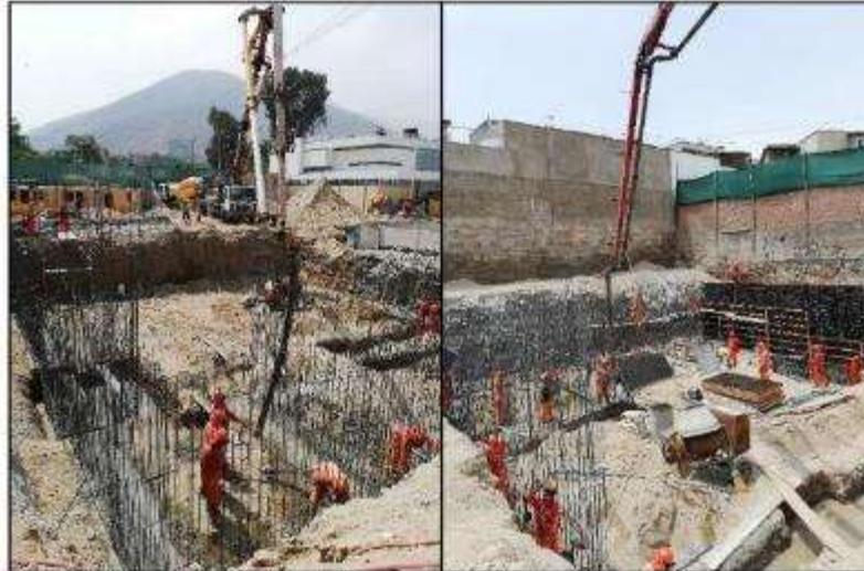
FOTO N° 05: Se aprecia el vaciado de cimentación para muros en sótano.
