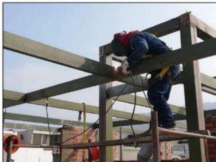
Foto N° 02: Se aprecia la instalación de estructura metálica.
