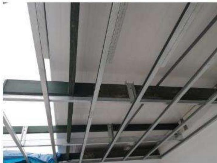
**Foto 20: Instalación de panel termoaislante TAT 1060.**
