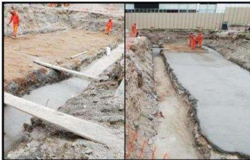
Foto N° 02: Se aprecia el vaciado de solado luego de concluir con la excavación de cemento y la nivelación del fondo de piscina.
