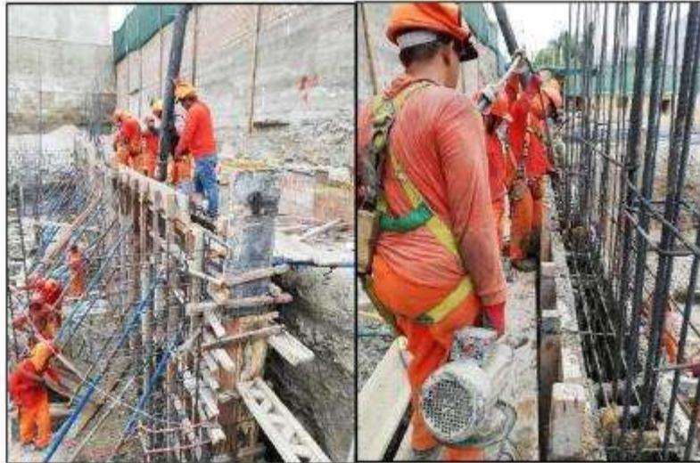
FOTO N° 07: Se aprecia el vaciado y vibración de muros en sótano.
