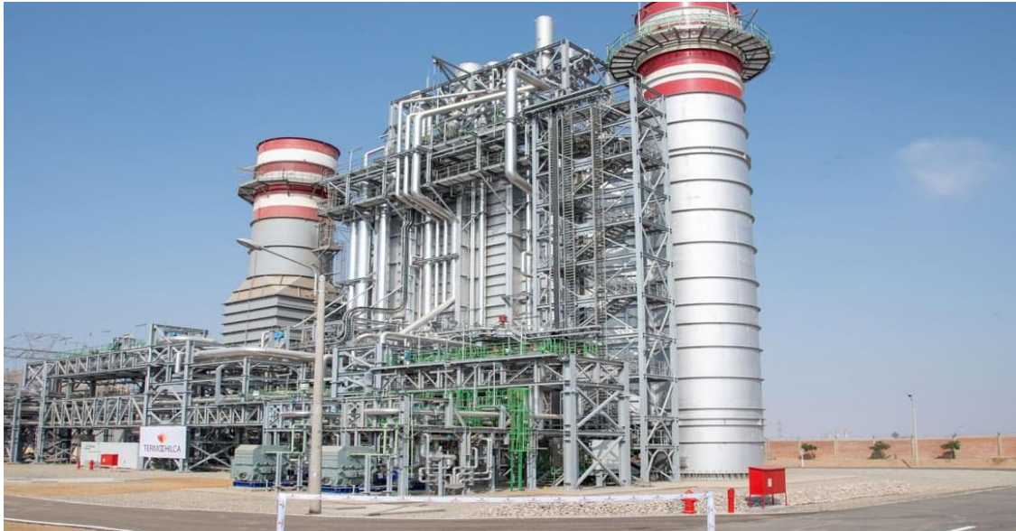
Figura N° 3. Turbinas de generación eléctrica
