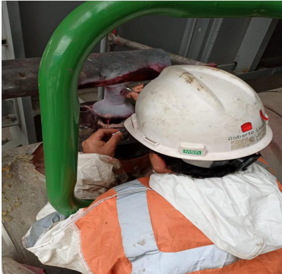
Figura N° 11. Prueba no destructiva líquidos penetrantes Fuente: Elaboración propia.
