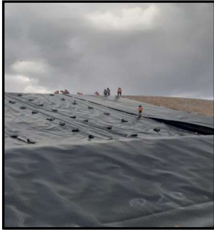
Figura 59. Colocación de geomembrana.
