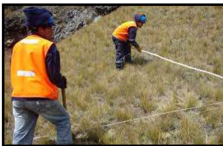
Figura 4. Revegetación en taludes plataformado de arcilla
