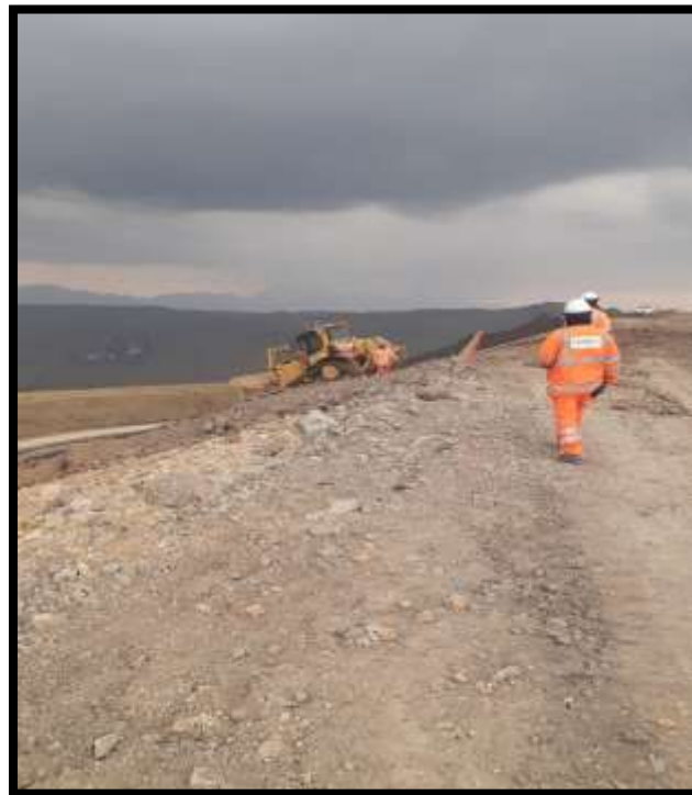
Figura 58. Conformación de taludes para pruebas de panel test.
