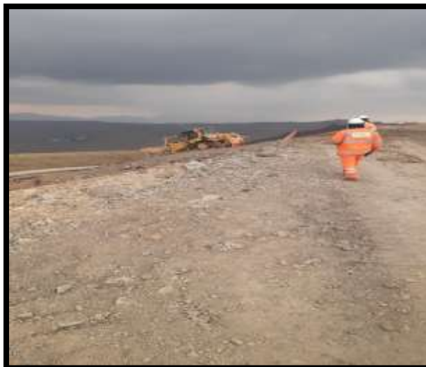
Figura 23. Estabilización del talud de prueba
